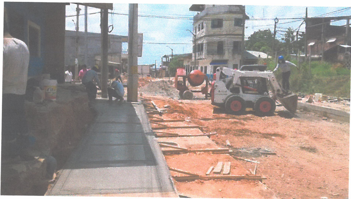
VISTA DE LA SUB BASE Y ACABADOS EN VEREDA
