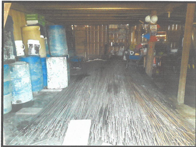
ALMACÉN DE OBRA Y VISTA DE MATERIALES
