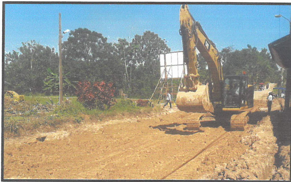
CONFORMACION DE TERRENO CON MAQUINARIA
