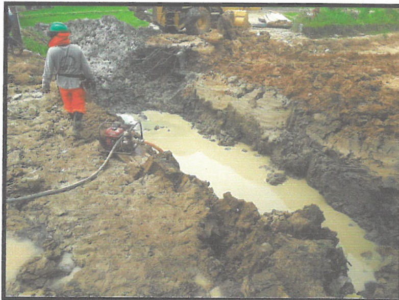
BOMBEO DE AGUA EN ZANJA C/MOTOBOMBA
