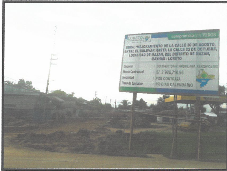
VISTA DEL CARTEL DE OBRA
