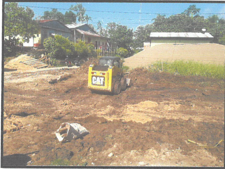
ELIMINACION DE MATERIAL EXCEDENTE
