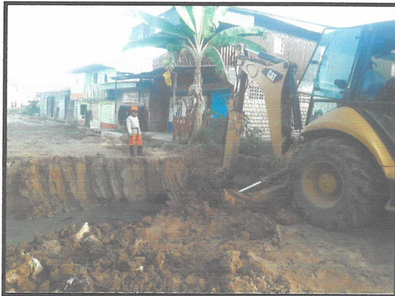
DEMOLICION DE ALCANTARILLA 0+203.5
