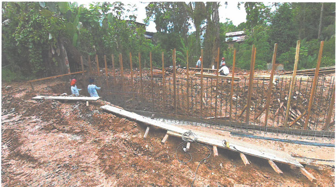
FOTO N° 12: EN LA VISTA SE OBSERVA EN VACEADO DE CONCRETO EN ZAPATA.
