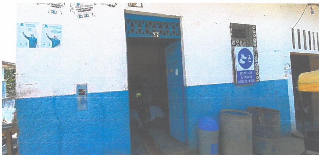
FOTO N° 14: EN LA VISTA SE OBSERVA EL ALMACEN DONDE ESTAN ACOPIADO LOS MATERIALES QUE SON DISTRIBUIDOS AL LUGAR DE TRABAJO.
