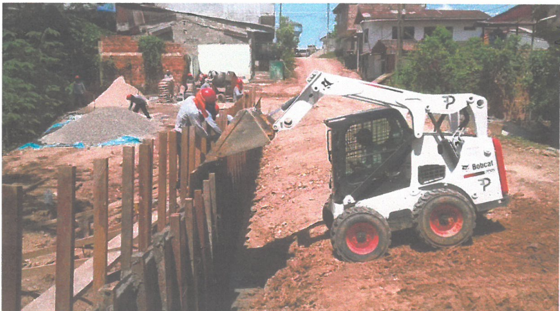
FOTO N° 06: EN LA VISTA SE OBSERVA AL PERSONAL REALIZANDO LOS TRABAJOS DE VASEADO DE CONCRETO EN MUROS DE CONTENCIÓN.
