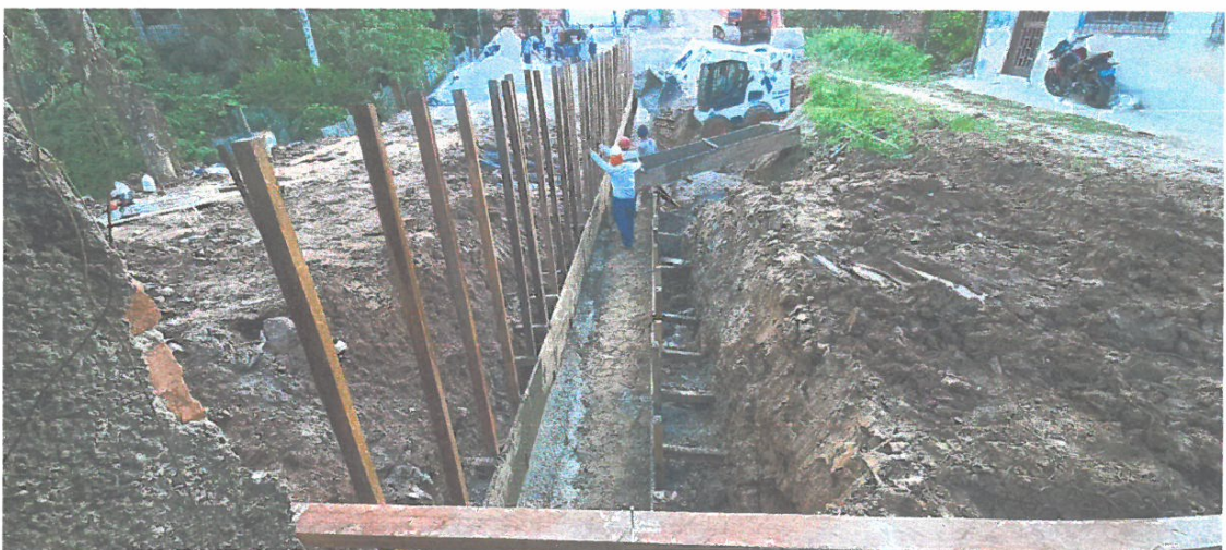
FOTO N° 08: EN LA VISTA SE OBSERVA EL TRABAJO DE RRELLENO CON MATERIAL DE PRESTAMO.
