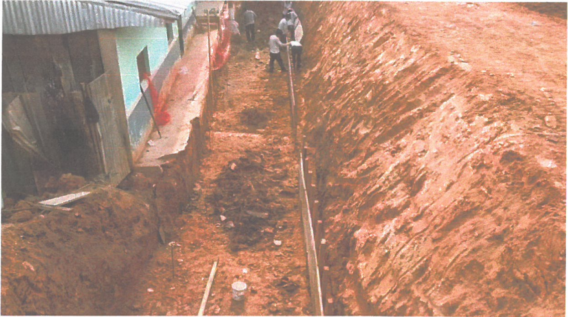
FOTO N° 03: EN LA VISTA SE OBSERVA AL PERSONAL REALIZANDO LOS TRABAJOS DE ENCOFRADO EN MUROS DE CONTENCIÓN.
