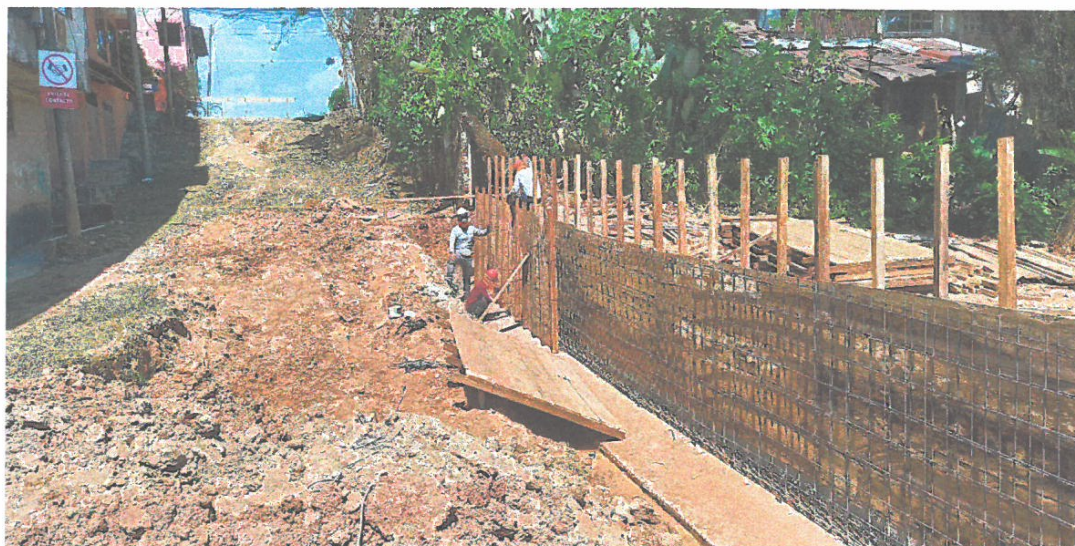
FOTO N° 13: EN LA VISTA SE OBSERVA AL PERSONAL REALIZANDO LOS TRABAJOS DE ANCLADO DE ACERO HORIZONTALES EN MURO.
