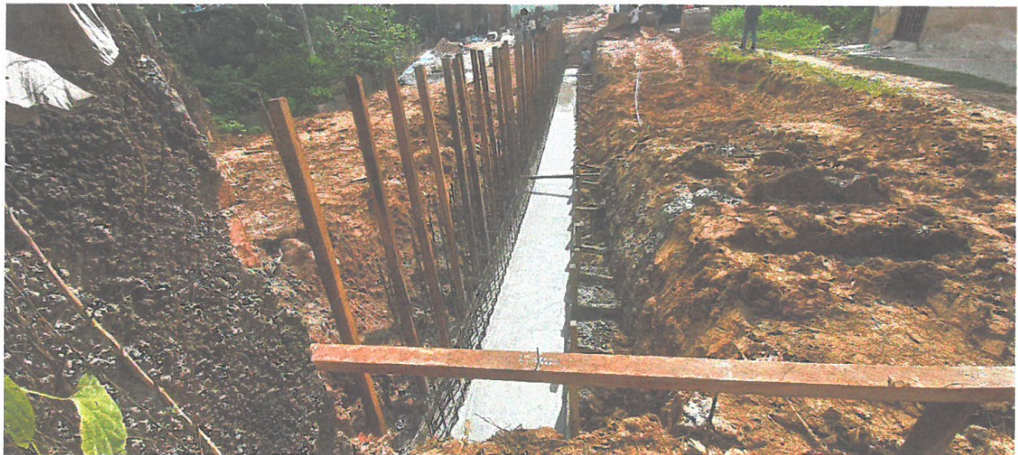
FOTO N° 11: EN LA VISTA SE OBSERVA LOS TRABAJOS ANCLAJE DE ACERO EN ZAPATA.
