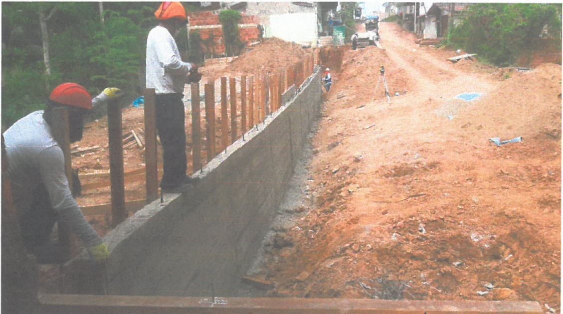
FOTO N° 04: EN LA VISTA SE OBSERVA AL PERSONAL REALIZANDO LOS TRABAJOS DE DESENCOFRADO DE MUROS.
