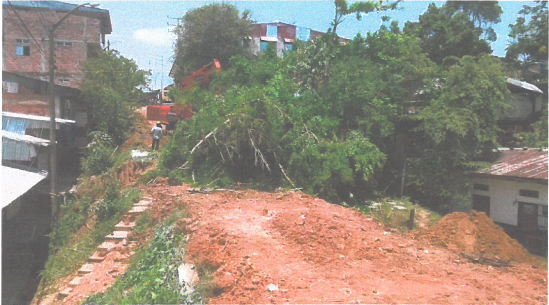
FOTO N° 01: EN LA VISTA SE OBSERVA AL EQUIPO DE MAQUINARIAS RELISANDO LOS TRABAJOS DE LIMPIEZA DE TERRENO.
