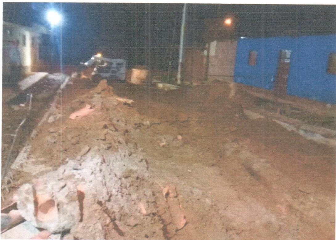
RELLENO COMPACTADO FINAL DE ZANJAS.
