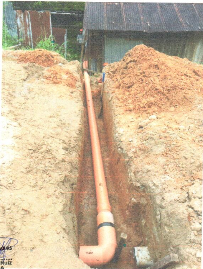
DESVIO PROVISIONAL DEL COLECTOR DE LA CALLE MALAPI HACIA LA ALCANTARILLA EXISTENTE..
