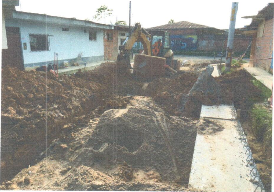
EXCAVACION DE ZANJA PARA DESAGUE.
