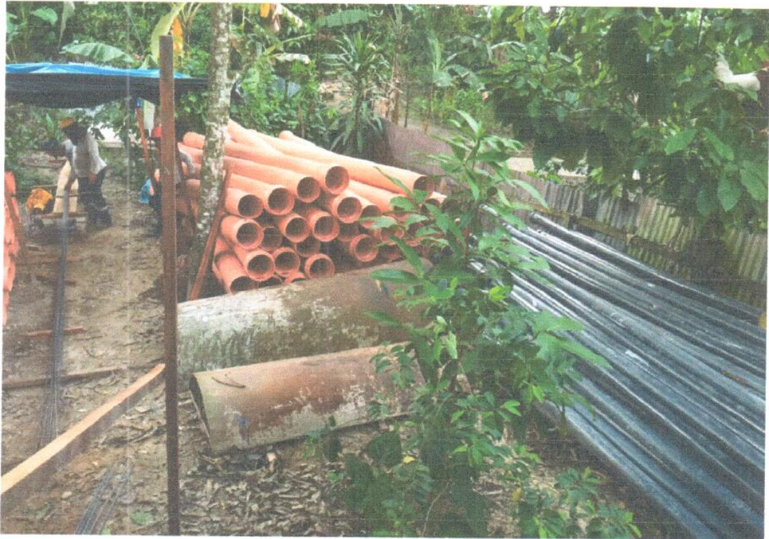
TUBERIAS PARA AGUA LAS GRISES Y LAS DE DESAGUE LA NARANJAS, ALMACENADAS EN OBRA.
