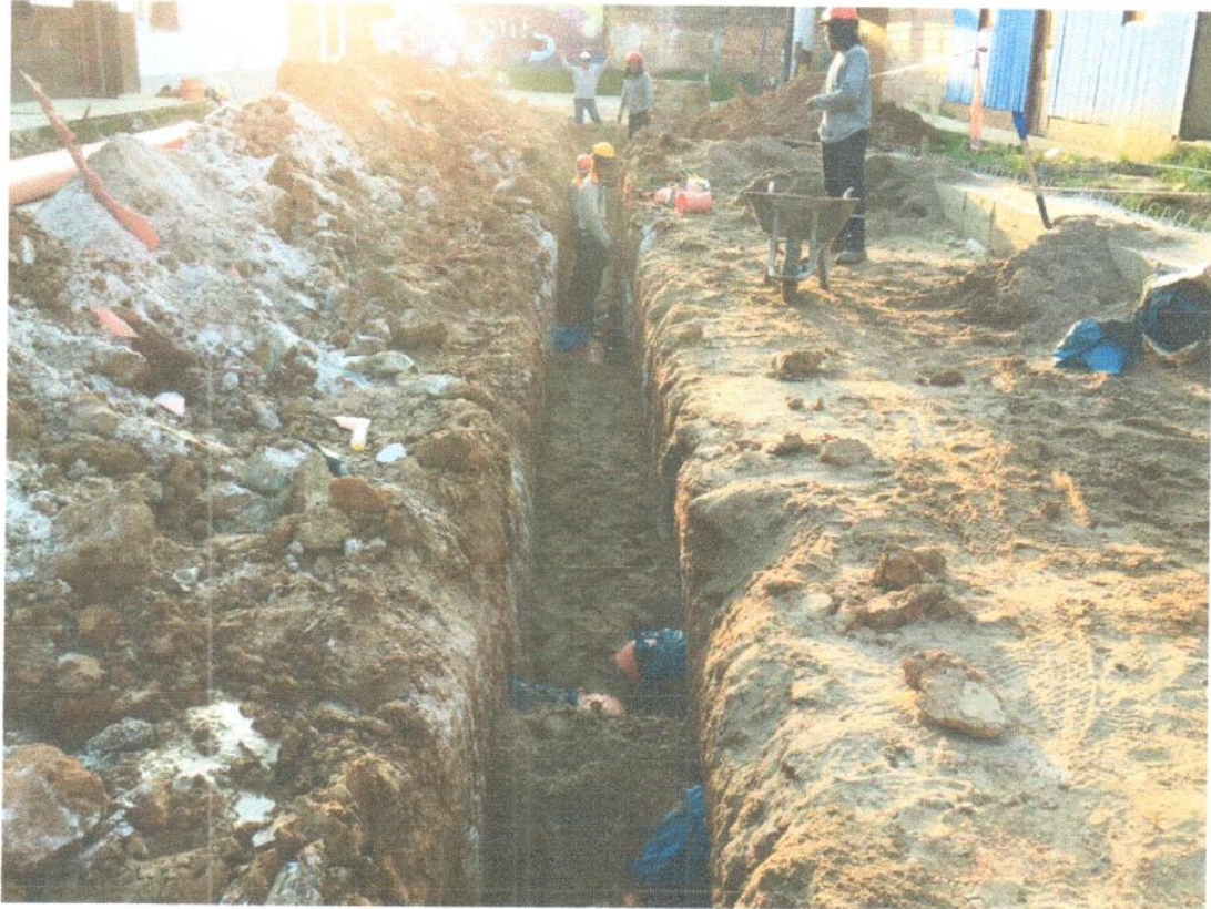
PROTECCION DE LA TUBERIA PVC UF S20 250mm CON ARENA GRUESA.
