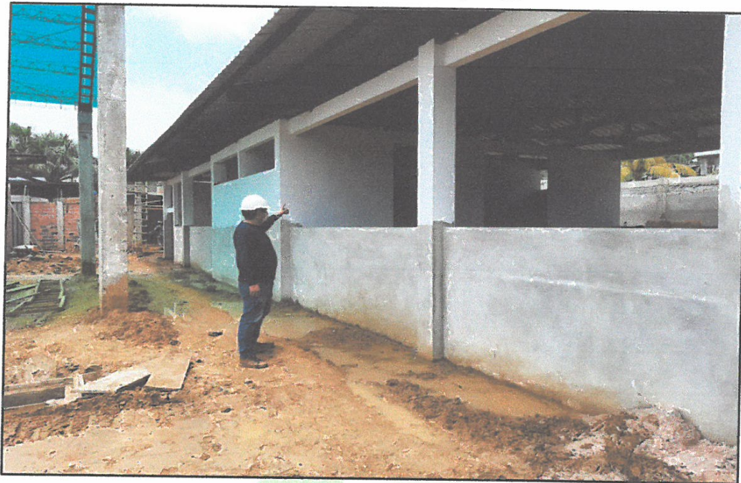
FOTO N°05: TRABAJOS DE PINTURA EN AMBIENTES INTERIORES Y EXTERIORES EN MODULOS
