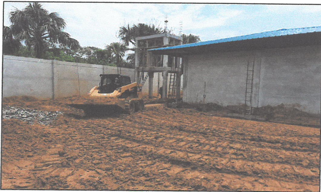
FOTO N°01: VISTA PANORÁMICA DE LOS TRABAJOS DE OBRA, SE OBSERVA TRABAJOS DE CORTE DE MATERIAL SATURADO, Y ELIMINACION DEL MISMO PARA REPLAZO CON MATERIAL DE CANTERA.
