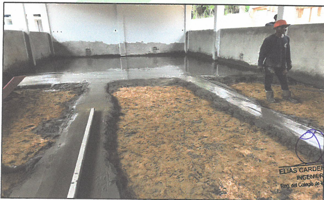
FOTO N° 10: VACEO DE MORTERO EN PISO, DEBIDAMENTE COMPACTADOS.
