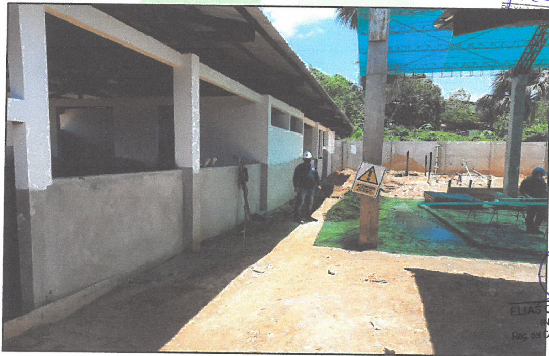
FOTO N°06: TRABAJOS DE PINTURA EN AMBIENTES INTERIORES Y EXTERIORES EN MODULOS.
