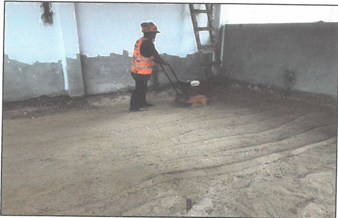
FOTO N° 09: RELLENO CON MATERIAL DE PRÉSTAMO, COMPACTACIÓN EN PISOS DE MODULOS.
