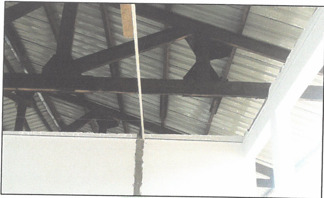
FOTO N° 17: COLOCACION DE PERFILES DE ALUMINIO PARA INSTALACIÓN DE CIELORRAZO.
