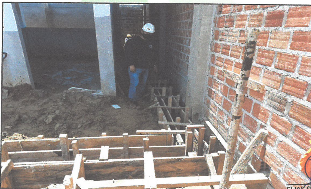
FOTO N° 07: ENCOFRADO DE CUNETAS EN MODULO IV, Y VACEO DE MORTERO EN CUNETAS.
