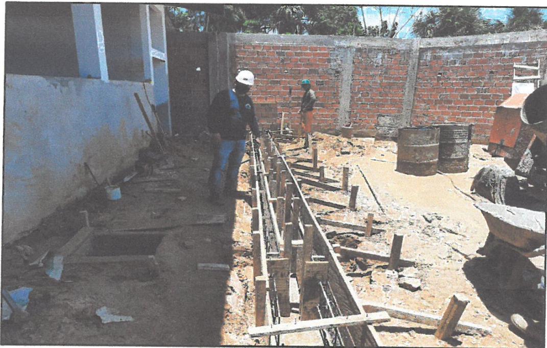
FOTO N° 07: ENCOFRADO DE CUNETAS EN MODULO IV, Y VACEO DE MORTERO EN CUNETAS.
