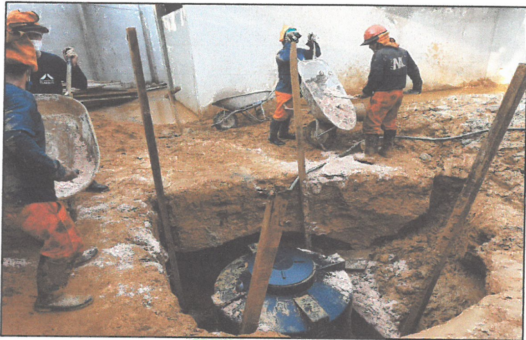
FOTO N°03: INSTALACIÓN DE TANQUES BIODIGESTOR EN OBRA
