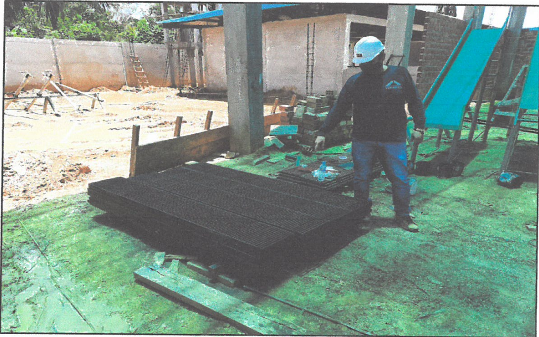
FOTO N° 11: CONFECCIÓN DE REJILLAS METÁLICAS PARA CUNETAS.
