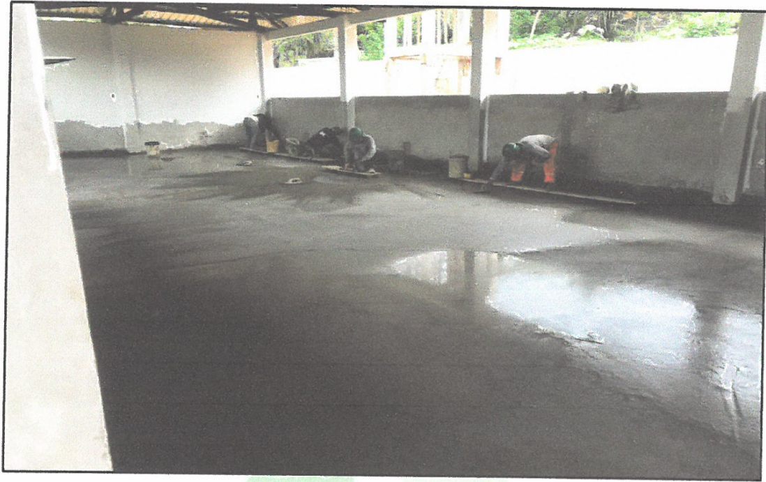
FOTO N° 15: PULIDO DE PISOS EN INTERIORES DE AMBIENTES
