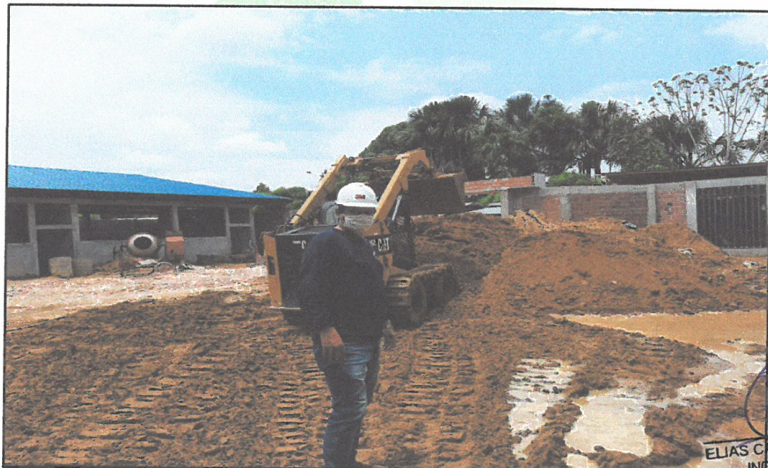
FOTO N°01: VISTA PANORÁMICA DE LOS TRABAJOS DE OBRA, SE OBSERVA TRABAJOS DE CORTE DE MATERIAL SATURADO, Y ELIMINACION DEL MISMO PARA REPLAZO CON MATERIAL DE CANTERA.
