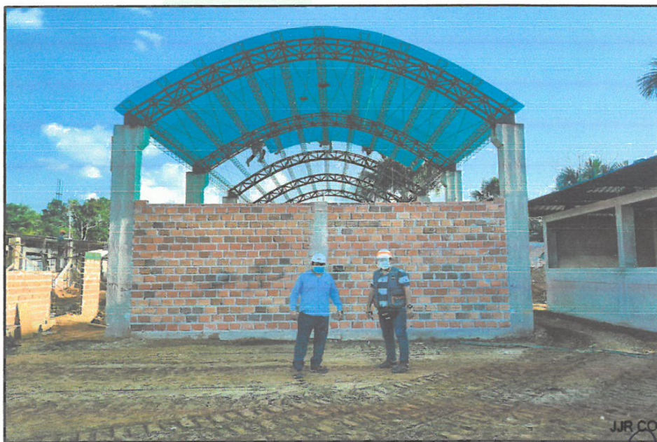
FOTO N°12: INSTALACIÓN DE PLANCHAS DE POLICARBONATO EN COBERTURA DE PATIO DE FROMACIÓN.
