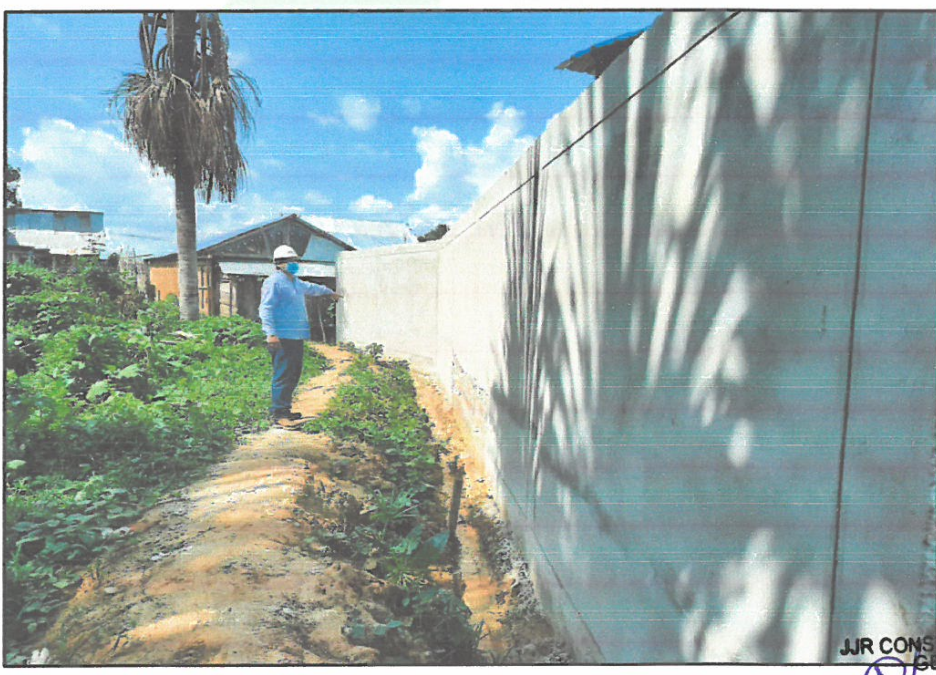
FOTO N°04: TARRAJEADO EN MURO EXTERIOR DE CERCO PERIMÉTRICO.
