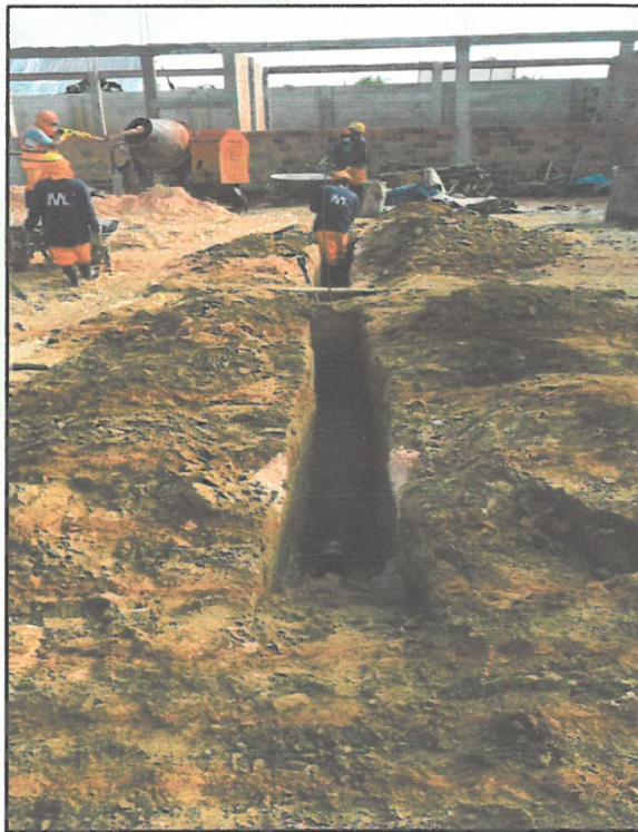
FOTO N° 17: EXCAVACIÓN DE ZANJAS, INSTALACION DE TUBERIA PERFORADA CON MANTO GEOTEXTIL, RELLENO CON MATERIAL DE RELLENO DEBIDAMENTE COMPACTADO, TRABAJOS PARA SUB. DREN.
