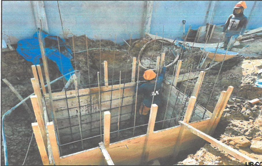
FOTO N°10: COLOCACIÓN DE ESTRUCTURA PARA CISTERNA, Y VACEO DE MORTERO EN LOSA INFERIOR DE CISTERNA
