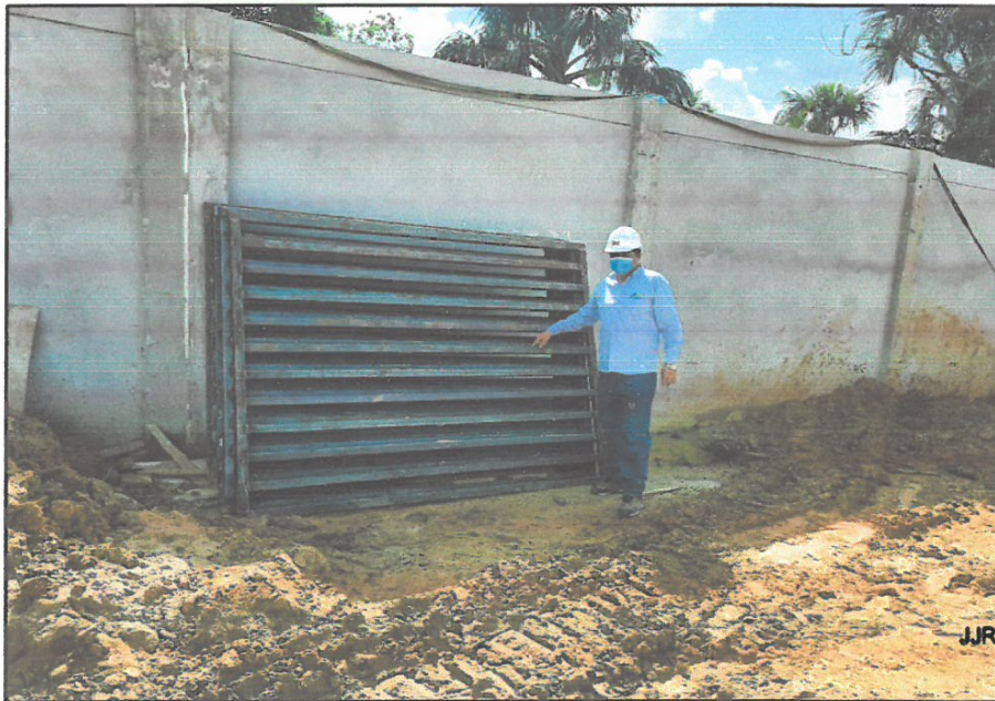
FOTO N°06: CONFECCIÓN DE VENTANA CON ACERO CUADRADO DE 2" X2 PARA FACHADA DE IE.
