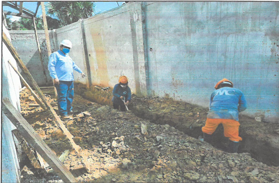
FOTO N° 15: EXCAVACIÓN DE ZANJAS PARA SUB. DREN.
