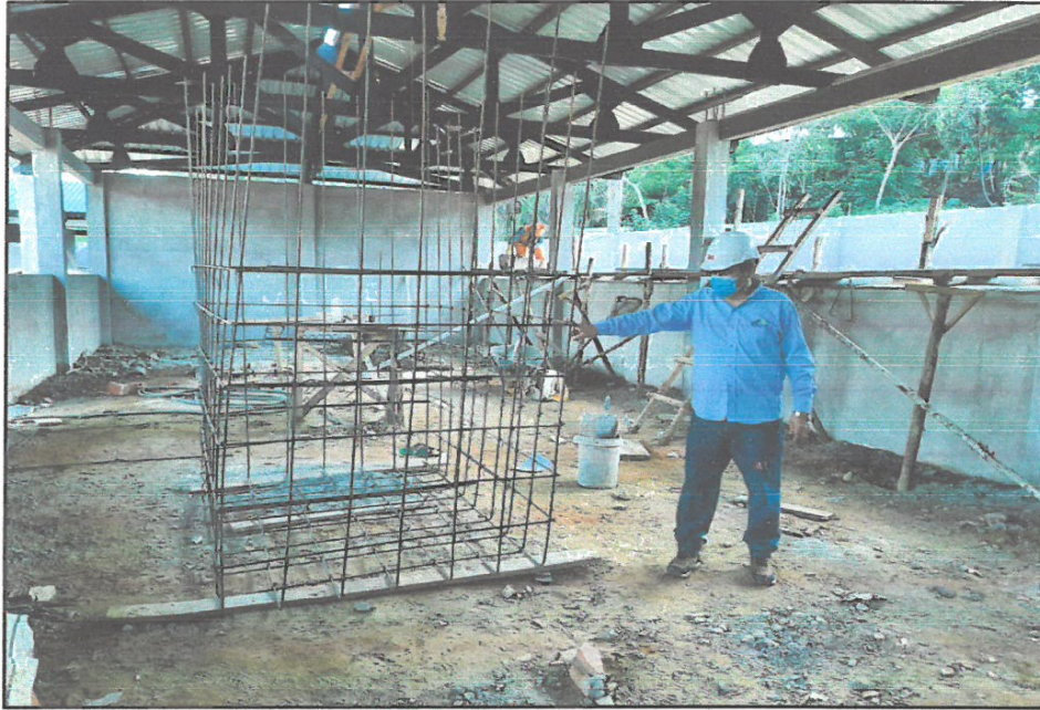
FOTO N°09: HABILITACIÓN DE ACERO CORRUGADO EN CISTERNA
