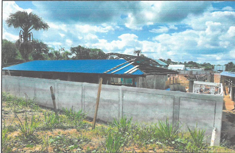
FOTO N°01: VISTA PANORÁMICA DE LOS TRABAJOS DE OBRA, SE OBSERVA TRABAJOS DE COBERTURA EN MODULOS Y PATIO DE FORMACIÓN ASI COMO TARRAJEO EN CERCO PERIMÉTRICO.
