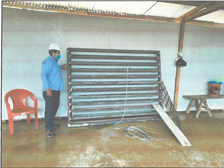
FOTO N° 05: CONFECCIÓN DE VENTANAS CON ACERO CUADRADO PARA FACHADA DE IE.
