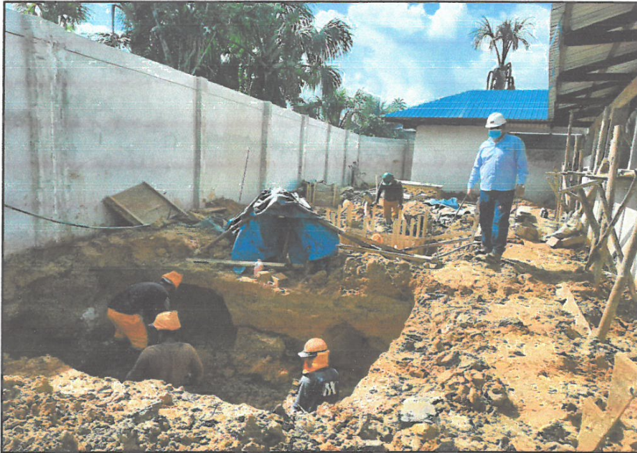
FOTO N°07: EXCAVACIÓN DE ZANJAS PARA PLATEA DE CIMENTACIÓN DE TANQUE ELEVADO, ASI COMO PARA LOSA INFERIOR DE CISTERNA
