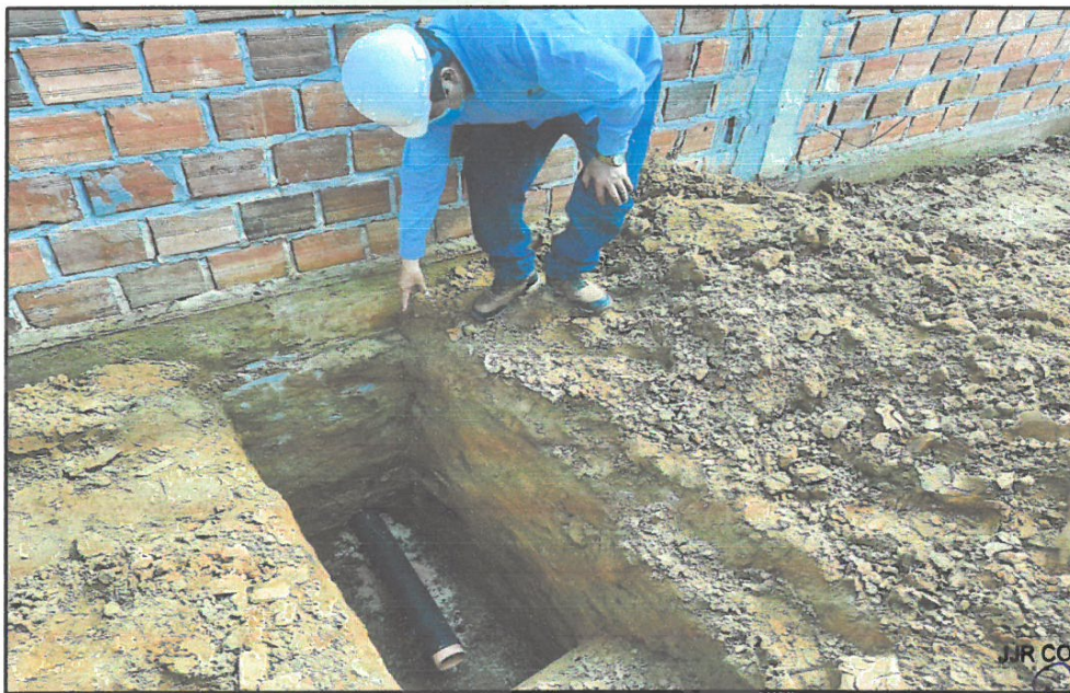
FOTO N° 16: INSTALACION DE TUBERÍA PARA SUB. DREN, CUBIERTO CON SU MANTO DE GEOTEXTIL DEBIDAMENTE PERFORADO.
