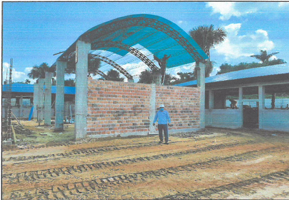
FOTO N°11: INSTALACION DE COBERTURA CON PLANCHAS DE POLICARBONATO EN PATIO DE FORMACIÓN.
