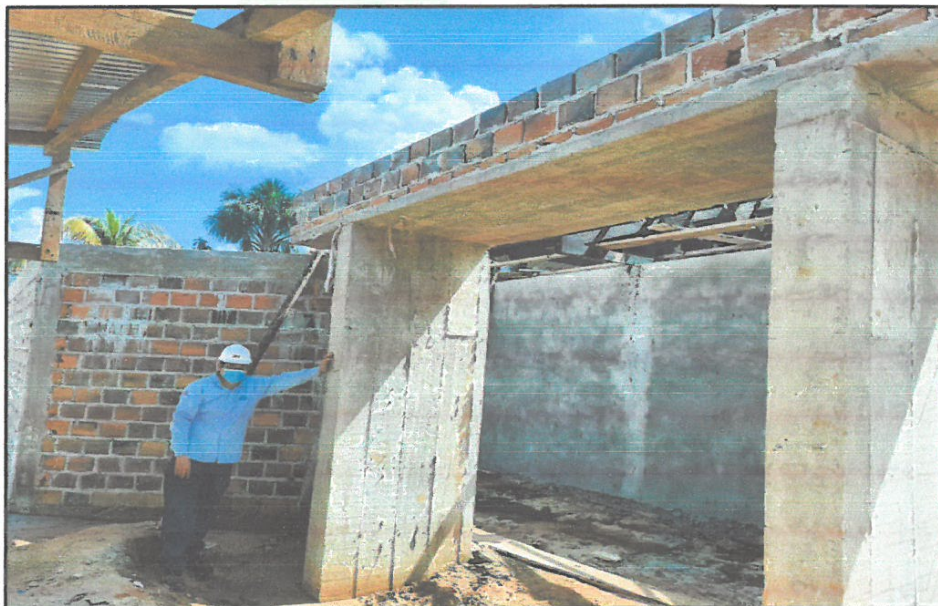
FOTO N°02: VISTA DE UNO DE LOS INGRESOS A LA IE, UMBRAL.
