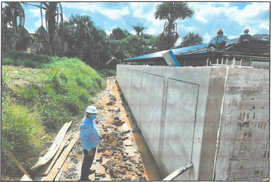
FOTO N°03: TARRAJEADO EN MURO EXTERIOR DE CERCO PERIMÉTRICO
