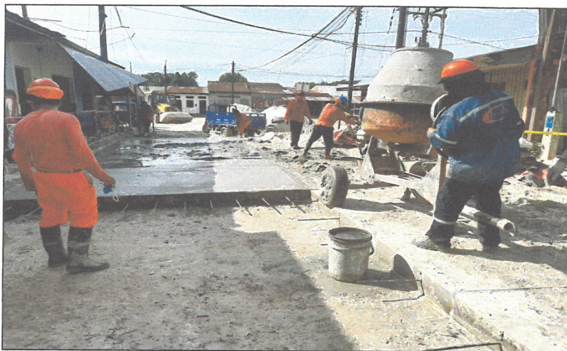
VISTA FOTOGRÁFICA N° 08: ENCOFRADO Y DEENCOFRADO EN LOSA RODADURA
