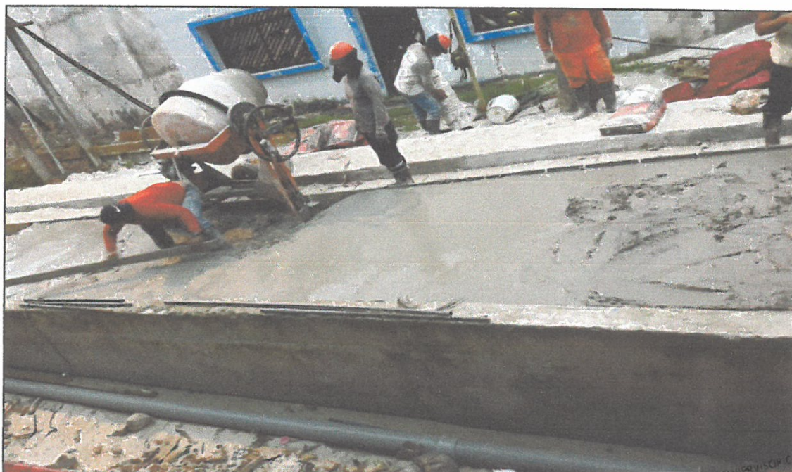
VISTA FOTOGRÁFICA N° 06: VACEADO DE LOSA DE RODADURA, Mortero f'c= 210 kg/cm 2 e=0.20 m.
