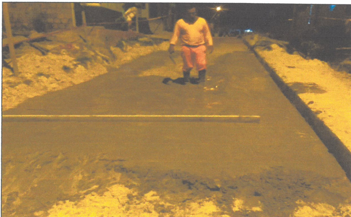
VISTA FOTOGRÁFICA N° 04: VACEADO DE SOLADO 1:10 C:A e= 4"
