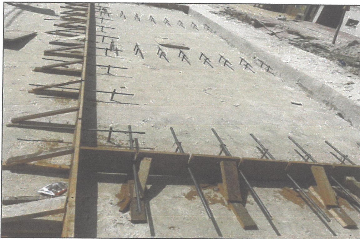
VISTA FOTOGRÁFICA N° 10: PASADOR DE FIERRO CORRUGADO Ø 5/8", en juntas de contracción
