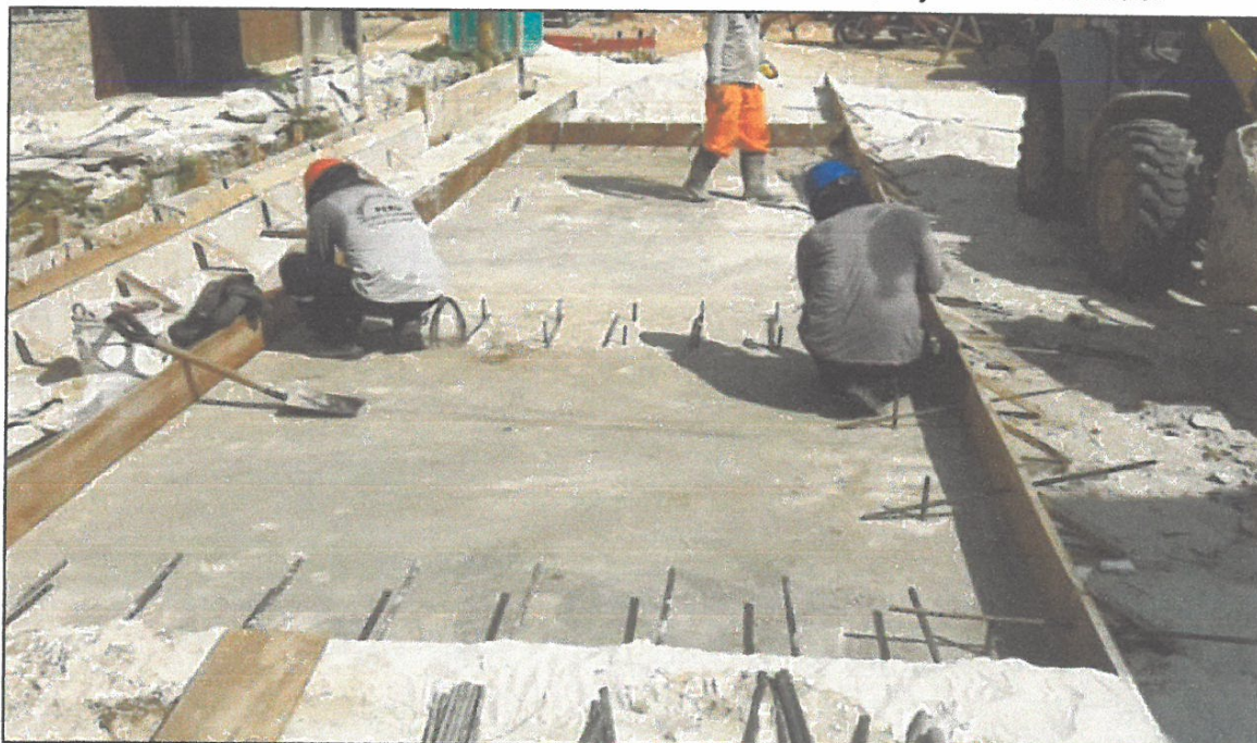
VISTA FOTOGRÁFICA N° 10: PASADOR DE FIERRO CORRUGADO Ø 5/8", en juntas de contracción
