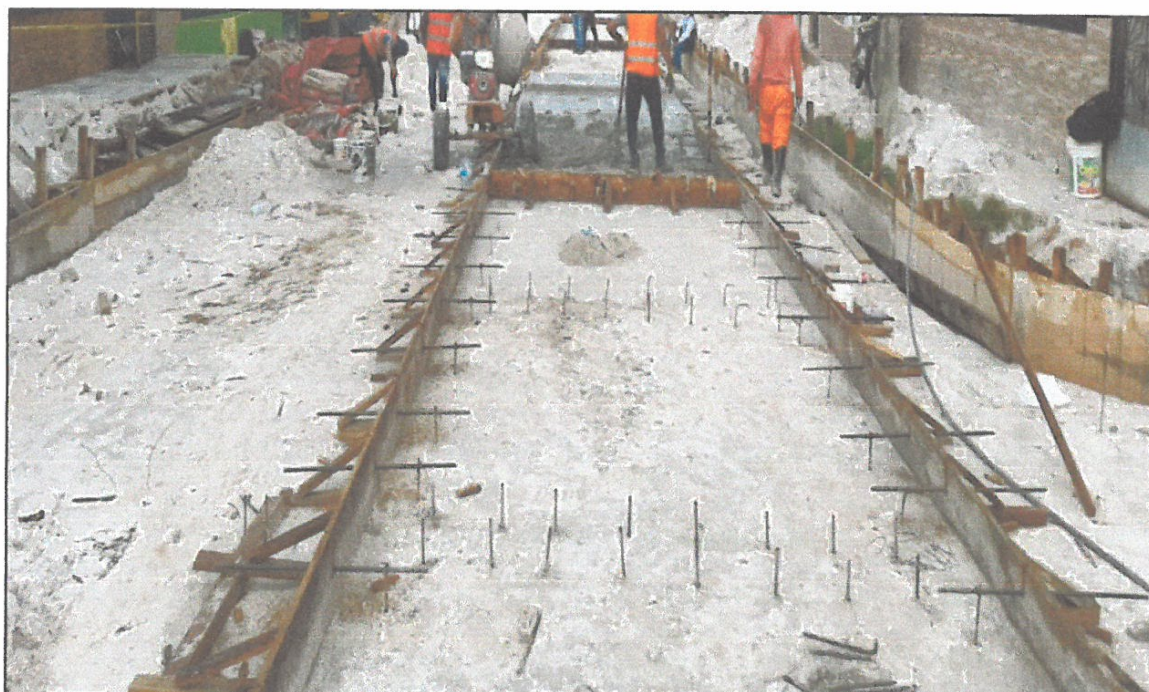
VISTA FOTOGRÁFICA N° 08: ENCOFRADO Y DEENCOFRADO EN LOSA RODADURA
