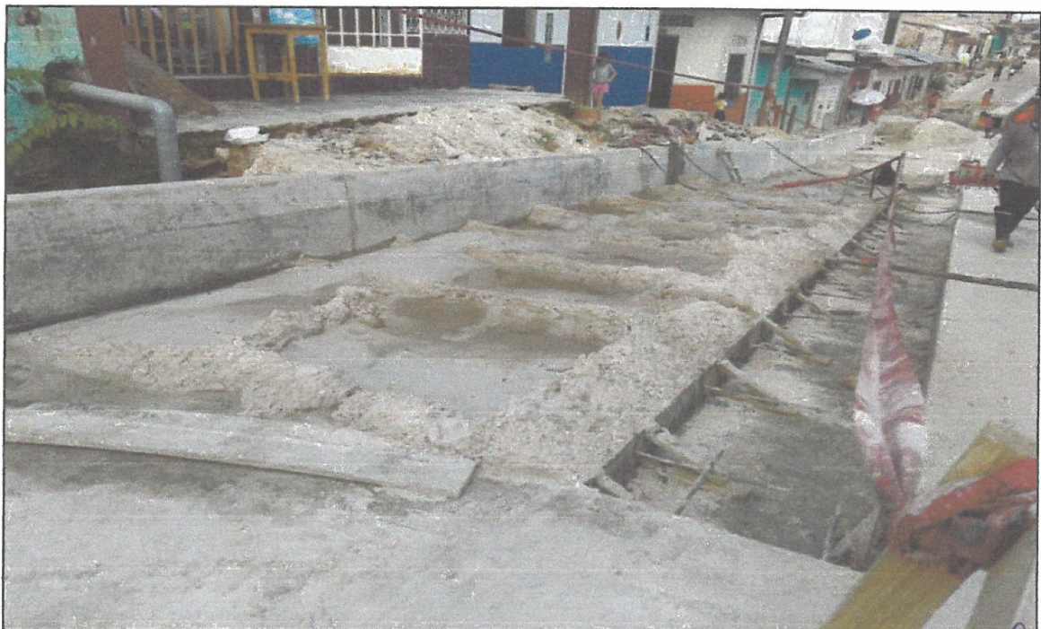
VISTA FOTOGRÁFICA N° 12: CURADO DE LOSA DE RODADURA, durante 7 días – 4 veces x día
