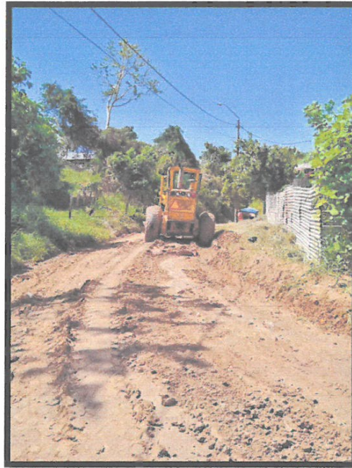
Figura 009. Vista del residente de obra, donde se observa trabajos de perfilado.
