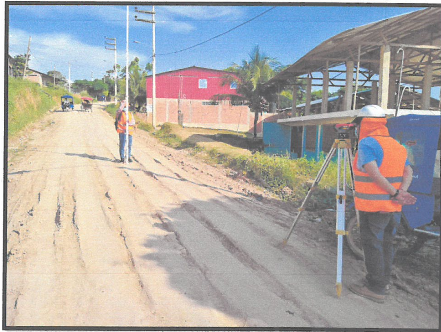
Figura 008. Vista del residente de obra, donde se observa trabajos de trazo nivel y replanteo de la obra.
