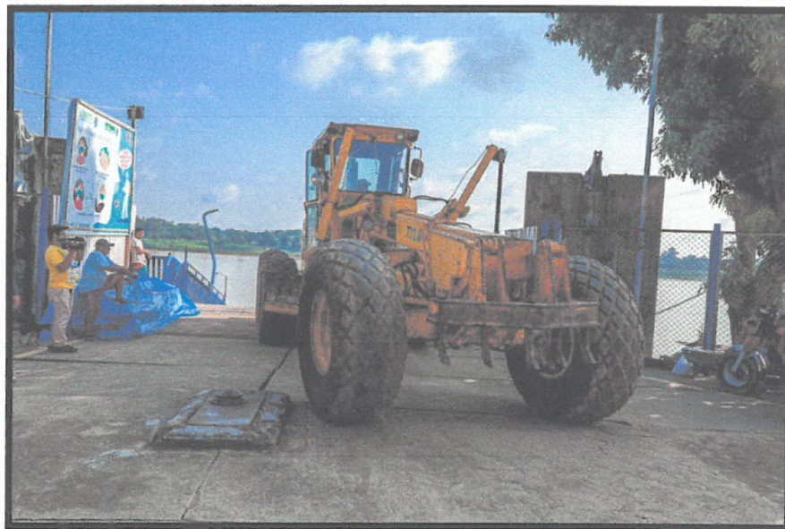
Figura 002. Vista del residente de obra, donde se observa trabajo de movilización de equipos para la obra
