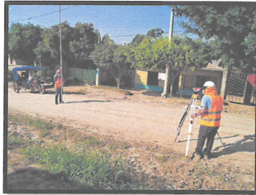
Figura 007. Vista del residente de obra, donde se observa trabajos trazo nivel y replanteo durante la obra.
