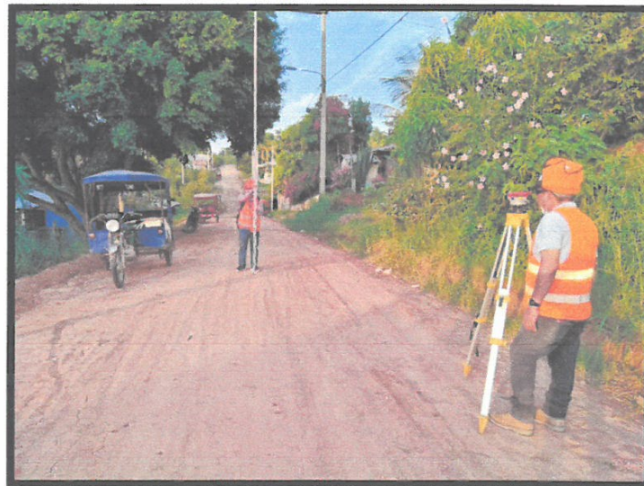
Figura 010. Vista del residente de obra, donde trabajos de topografía.
