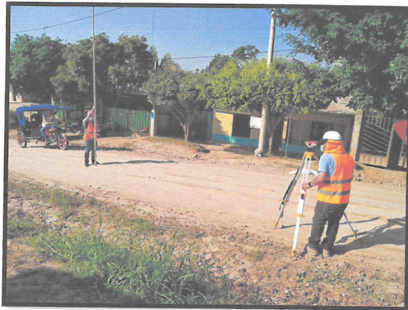
Figura 011. Vista del residente de obra, donde se observa trabajos de topografía.
