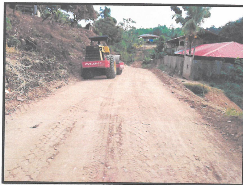
Figura 004. Vista del residente de obra, donde se observa compactación de afirmado
