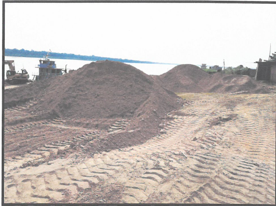
Figura 001. Vista del residente de obra, donde se observa la colocación de material de apoyo para material de afirmado
