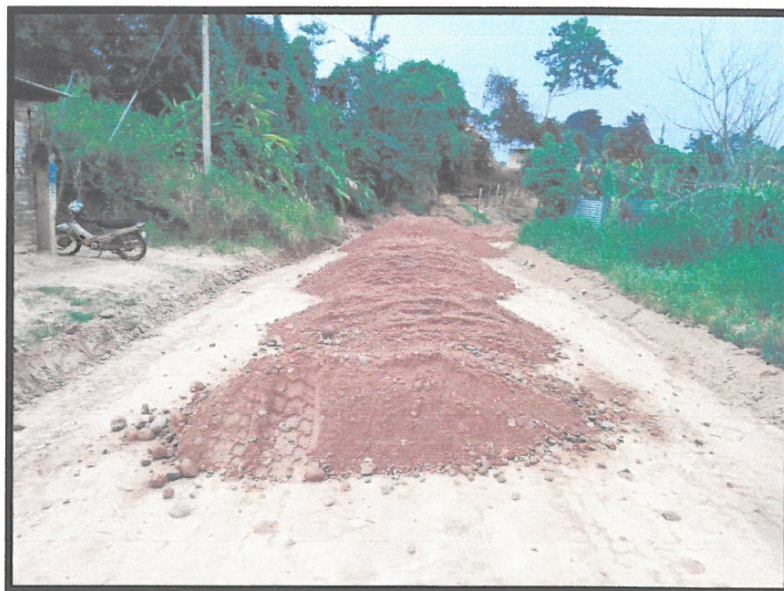
Figura 002. Vista del residente de obra, donde se observa trabajo de colocación de afirmado
