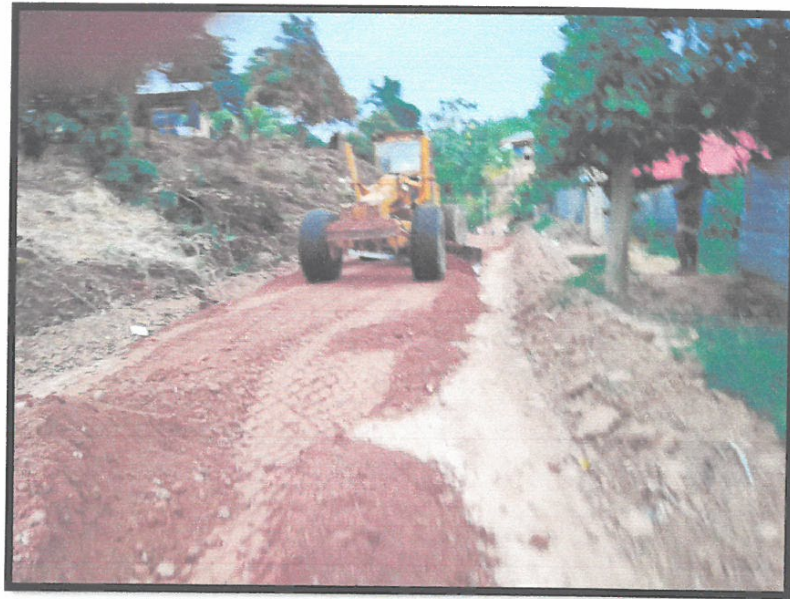
Figura 003. Vista del residente de obra, donde se observa colocación de afirmado
