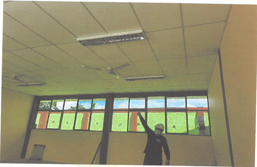
FOTO N° 09: INSTALACIÓN DE VENTILADORES 03 ASPAS
