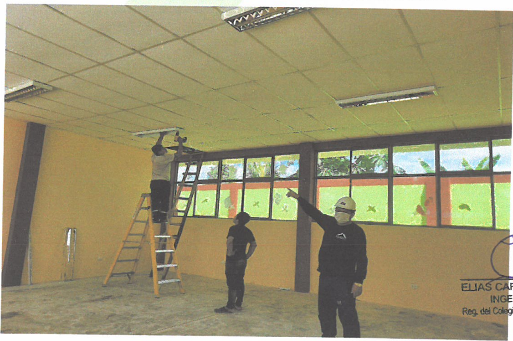
FOTO N°08: INSTALACION DE ARTEFACTOS FLUORESCENTES
