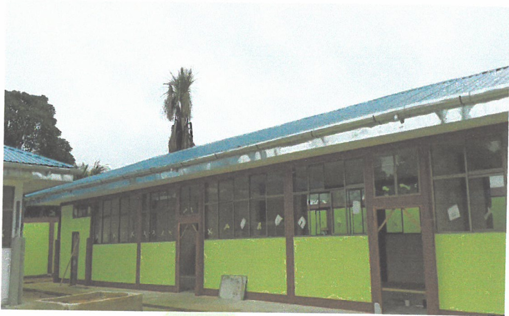
FOTO N° 05: SE OBSERVA TRABAJOS FINALES DE OBRA.
