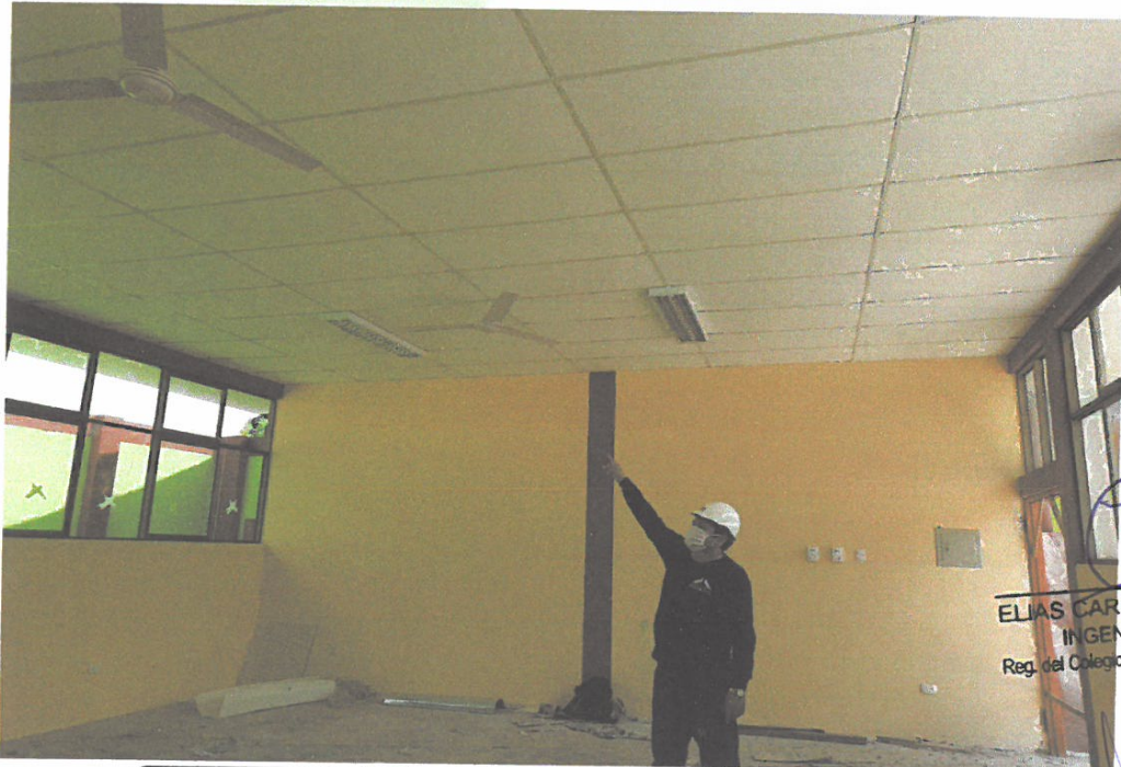
FOTO N° 10: INSTALACIÓN DE VENTILADORES 03 ASPAS
