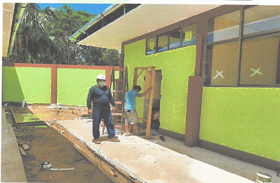
FOTO N°02: INSTALACIÓN DE PUERTAS EN MODULOS.
