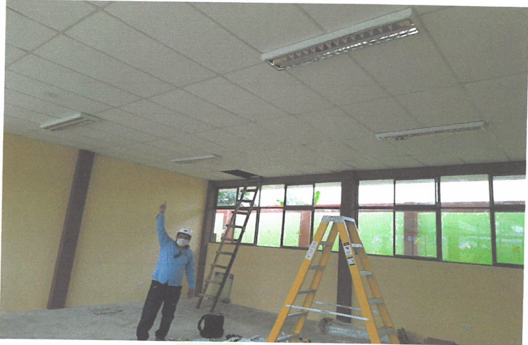
FOTO N° 07: INSTALACIÓN DE ARTEFACTOS FLUORESCENTES
