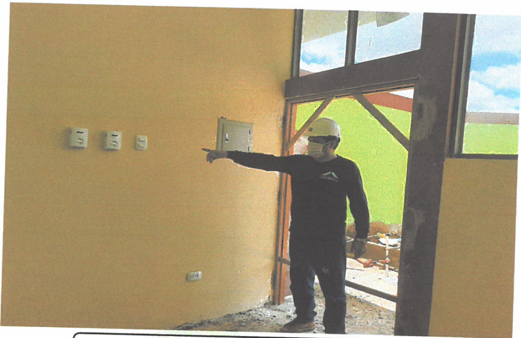
FOTO N°11: COLOCACIÓN DE TABLEROS DE CONTROL PARA VENTILADORES
