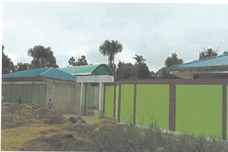
FOTO N°01: VISTA PANORAMICA DE FACHADA DE OBRA, TRABAJOS FINALES DE OBRA.
