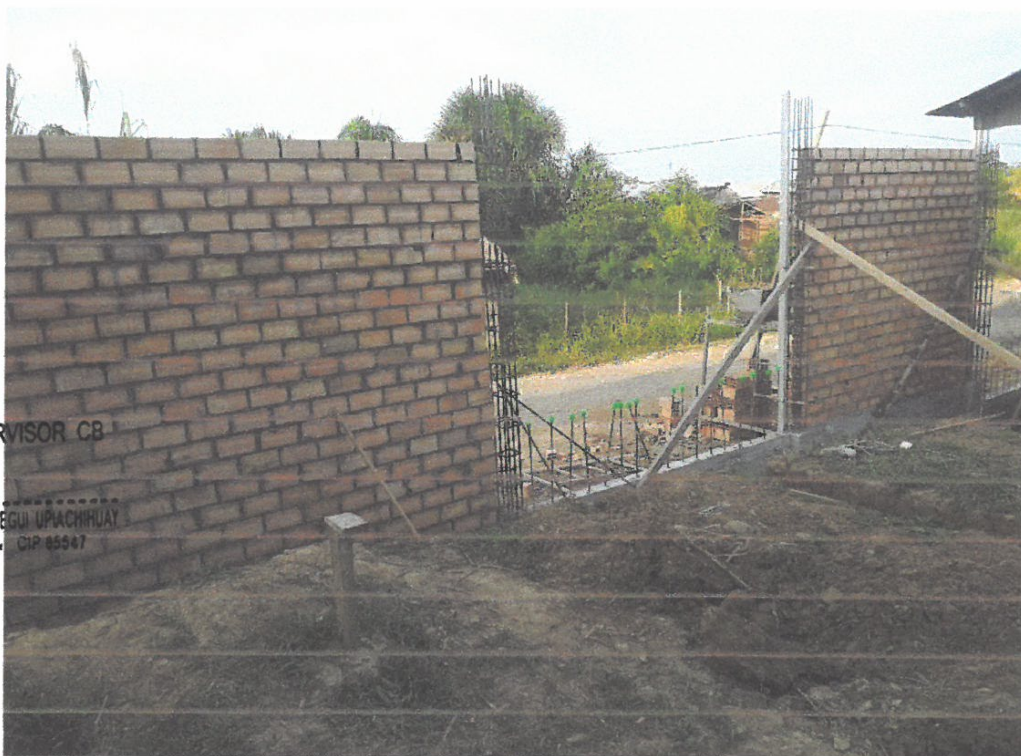
Foto N° 20: Vista del asentado de ladrillos de arcilla tipo sogá en el cerco perimétrico de la obra "Mejoramiento y Equipamiento del servicio Educativo N 62200 Barrio Carabanchel - San Lorenzo, Distrito Barranca, Provincia Datem Del Marañón - Loreto"
