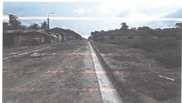
VACIADO DE CONCRETO F'C=175 KG/CM2, EN JR. 2 DE MAYO
