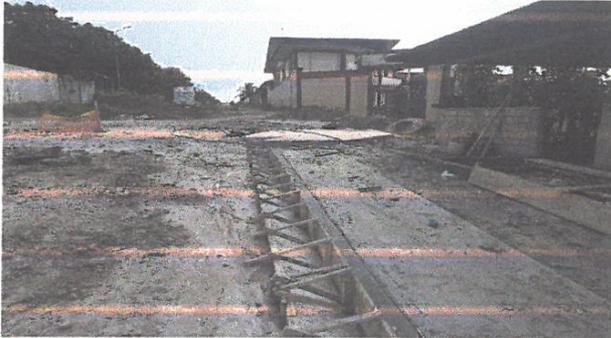
VACIADO DE CONCRETO F'C=175 KG/CM2 EN CUNETAS, EN JR. 2 DE MAYO
