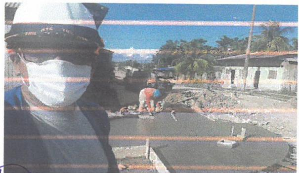
VACIADO DE CONCRETO F'C=175 KG/CM2 EN MARTILLOS Y RAMPAS, EN JR. 2 DE MAYO
