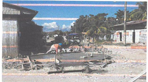
VACIADO DE CONCRETO F'C=175 KG/CM2 EN MARTILLOS Y RAMPAS, EN JR. 2 DE MAYO
