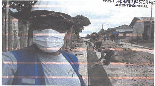
VACIADO DE CONCRETO F'C=175 KG/CM2 EN CUNETAS, EN JR. TRUJILLO
