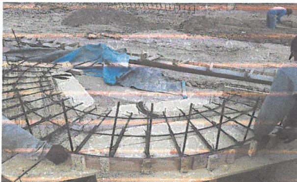
ENCOFRADO Y ACERO DE REFUERZO, LOSA Y ESPALDAR PARA BANCAS TIPO I, EN JR. 2 DE MAYO
