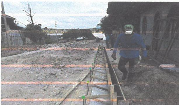
VACIADO DE CONCRETO F'C=175 KG/CM2 EN CUNETAS, EN JR. TRUJILLO
