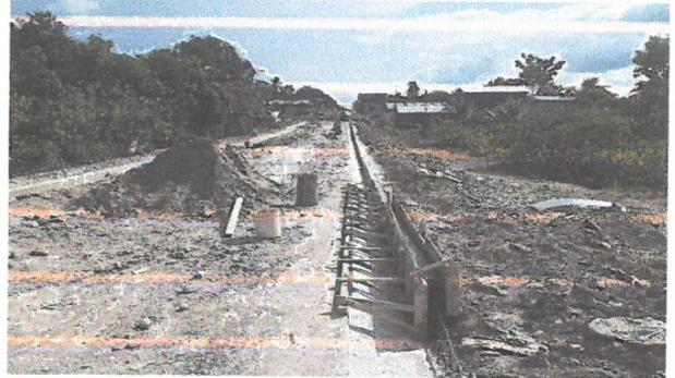
ENCOFRADO, ACERO Y VACIADO DE CUNETAS, EN JR. 2 DE MAYO
