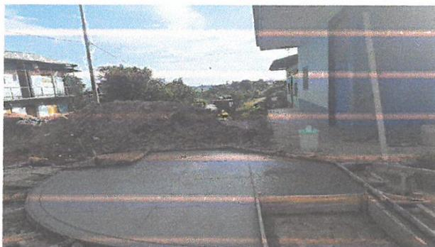
VACIADO DE CONCRETO F'C=175 KG/CM2 EN MARTILLOS Y RAMPAS, EN JR. TRUJILLO
