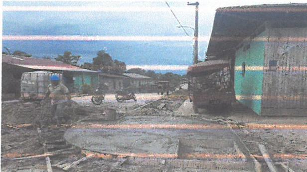
VACIADO DE CONCRETO F'C=175 KG/CM2 EN MARTILLOS Y RAMPAS, EN JR. TRUJILLO
