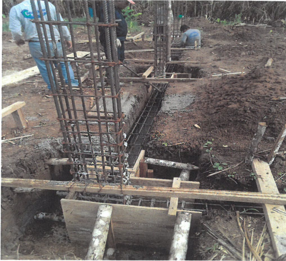
ENCOFRADO DE VIGAS DE CIMENTACIÓN
