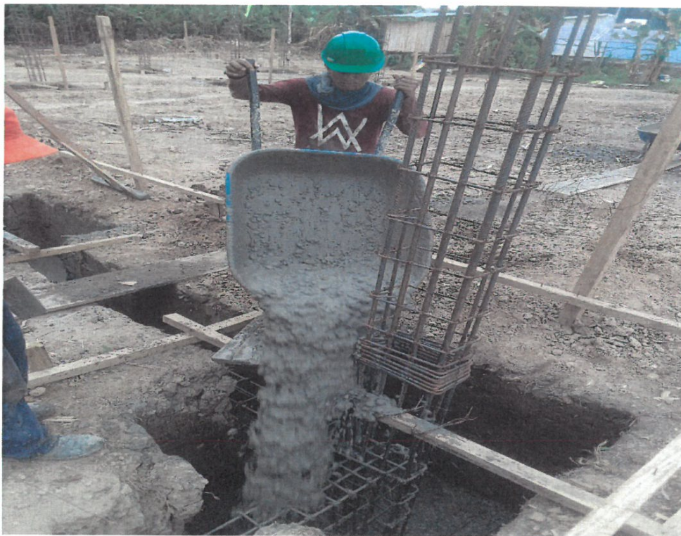
MORTERO f_c=175\text{kg/cm}^2 EN ZAPATAS
