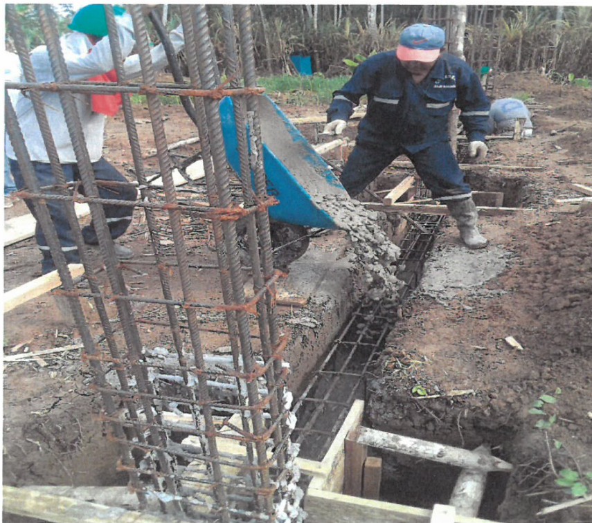
MORTERO F'C=210kg/cm2 PARA VIGA DE CIMENTACION
