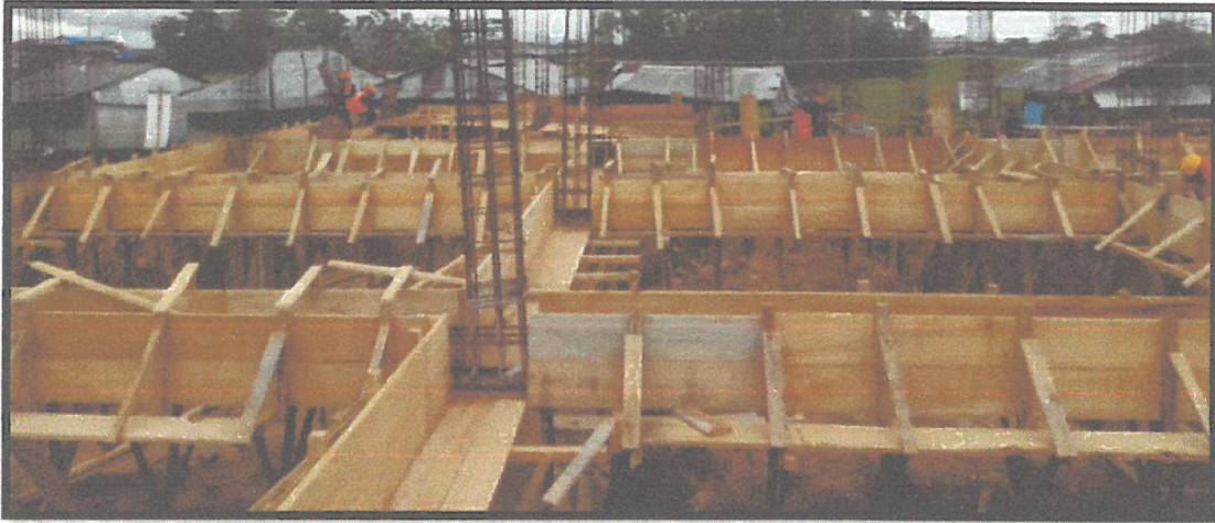
FOTO N°05: SE PUEDE OBSERVAR TRABAJOS DE ENCOFRADO DE LAS VIGAS PRINCIPALES
