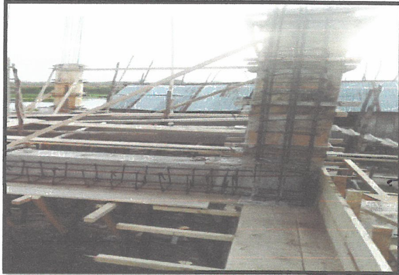
FOTO N°07: EN LA FOTO, SE MUESTRA LA HABILITACION DEL ACERO DE REFUERZO EN LAS COLUMNAS DE LA I.E
