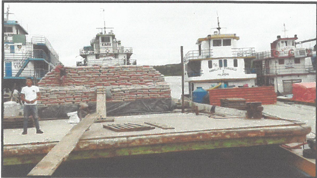
FOTO N°01: SE PUEDE OBSERVAR EL TRANSPORTE DE MATERIALES VIA FLUVIAL A TRAVES DE UNA EMBARCACION.
