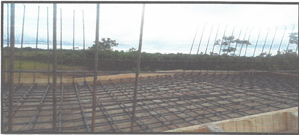
FOTO N°04: SE OBSERVA LOS TRABAJOS DE ENCOFRADOS PARA LA RAMPA, ADEMAS TAMBIEN SE OBSERVA LA HABILITACION DEL ACERO EN LA MISMA.
