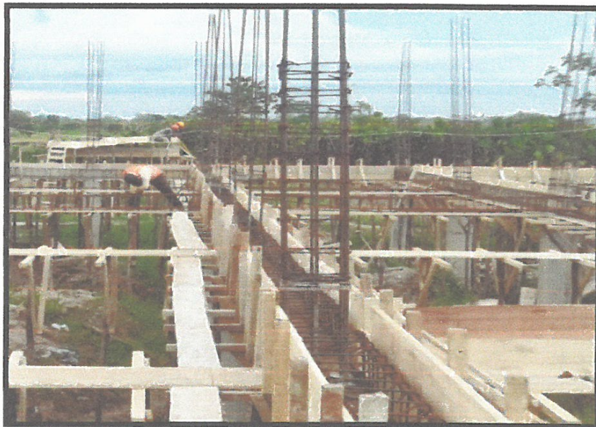
FOTO N°07: EN LA FOTO, SE MUESTRA LA HABILITACION DEL ACERO DE REFUERZO EN LAS COLUMNAS DE LA I.E
