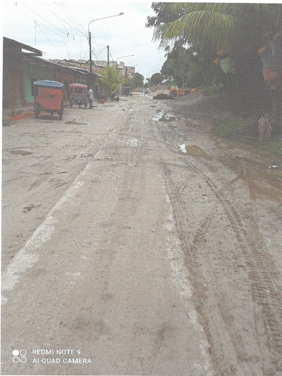
El tramo que se visualiza es de Calle Libertad en dirección hacia Pasaje Atlántida aún no inician labores, y solo existe colocación de materiales. Formaría del Plan de Monitoreo Arqueológico.
