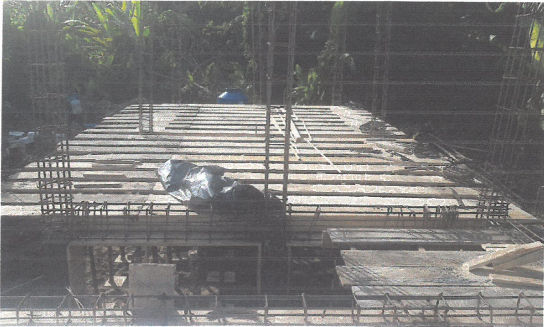
FOTO N°01: Se puede observar el trabajo de encofrado de madera para la losa aligerada.
