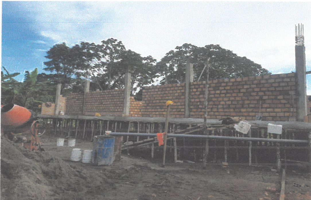
FOTO N°07: EN LA FOTO, se muestra la vista panorámica del estado de la obra
