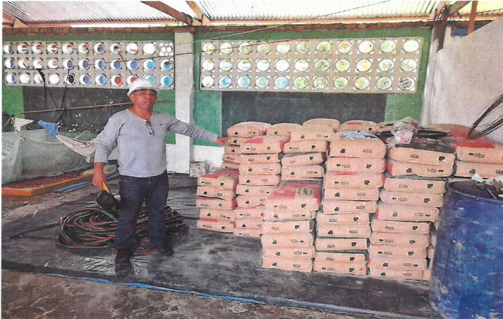
FOTO N°11: Acopio de cemento en el almacén de obra.
