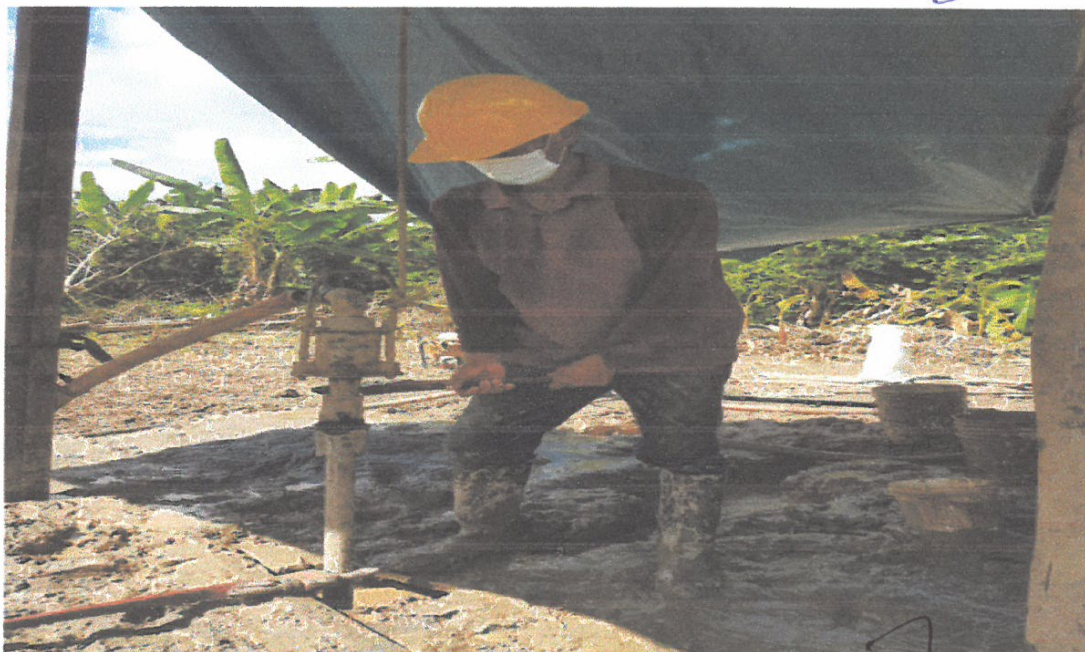
FOTO N°08: se muestra trabajos de perforación del pozo artesiano de gua para institución educativa
