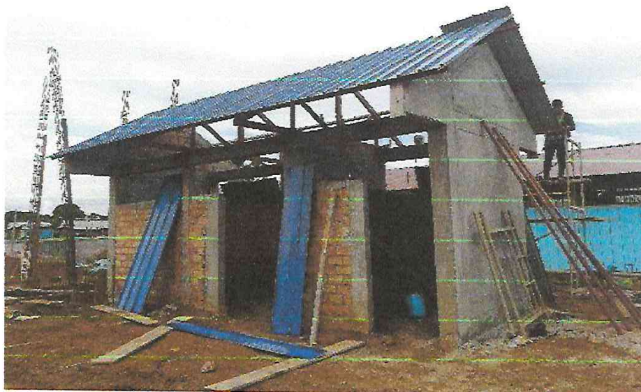
Foto N° 08: Vista del techado con TR5 del módulo la caseta y maestranza en la obra "Mejoramiento y Equipamiento del servicio Educativo N 62200 Barrio Carabanchel - San Lorenzo, Distrito Barranca, Provincia Datem Del Marañón - Loreto".
