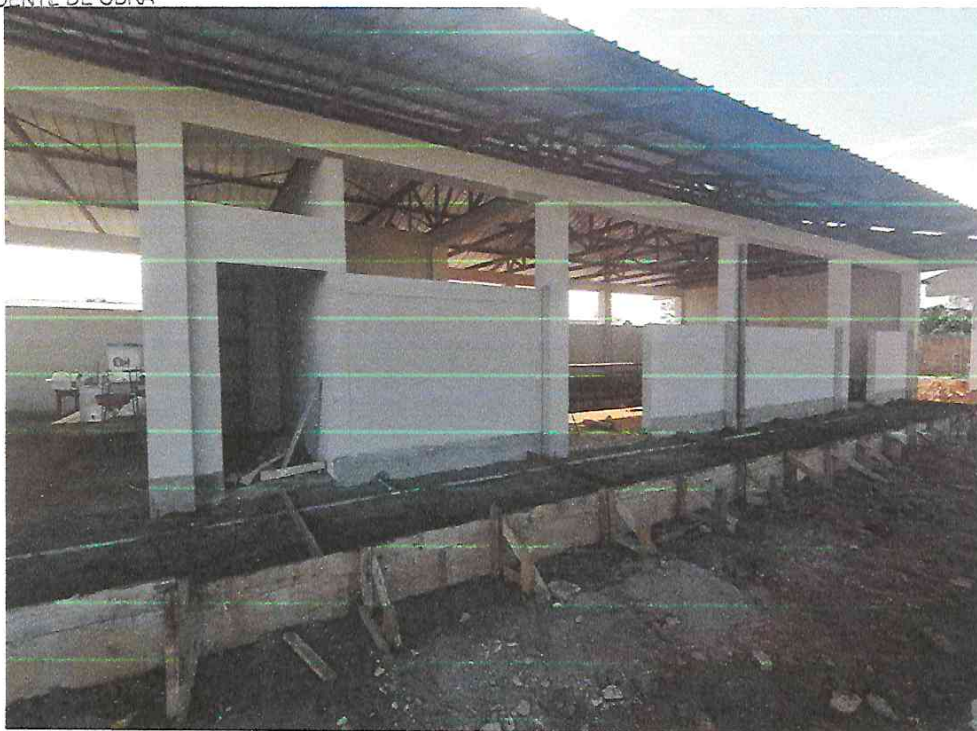
Foto N° 04: Vista del empastado de muros, columnas y vigas en la obra "Mejoramiento y Equipamiento del servicio Educativo N 62200 Barrio Carabanchel - San Lorenzo, Distrito Barranca, Provincia Datem Del Marañón - Loreto".
