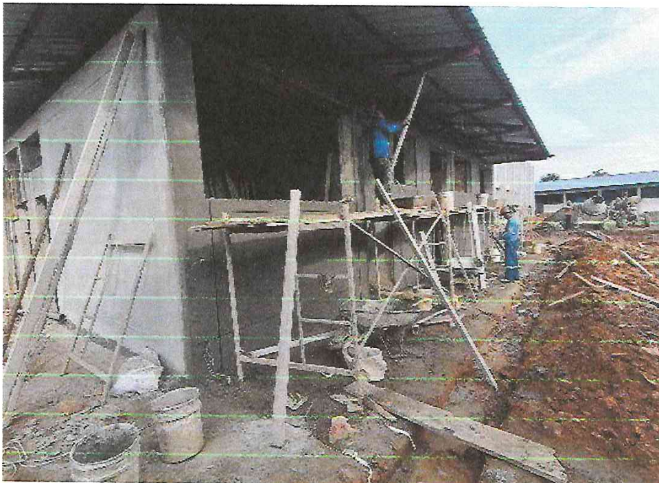
Foto N° 06: Vista del tarrajeo del módulo E en la obra "Mejoramiento y Equipamiento del servicio Educativo N 62200 Barrio Carabanchel - San Lorenzo, Distrito Barranca, Provincia Datem Del Marañón - Loreto".
