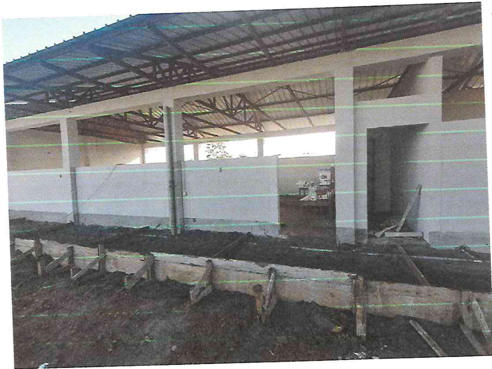
Foto Nº 09: Vista de los trabajos de empastado de muros y veredas en la obra "Mejoramiento y Equipamiento del servicio Educativo N 62200 Barrio Carabanchel - San Lorenzo, Distrito Barranca, Provincia Datem Del Marañón - Loreto".
