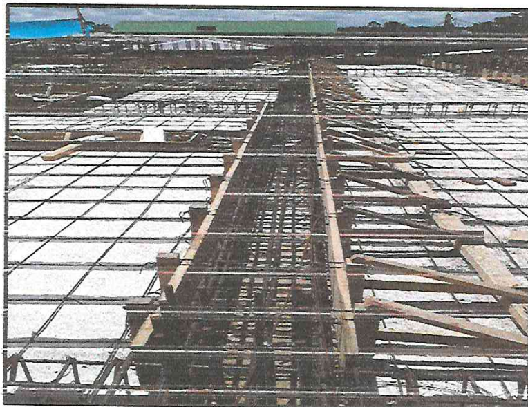
ENCOFRADO DE VIGAS.
