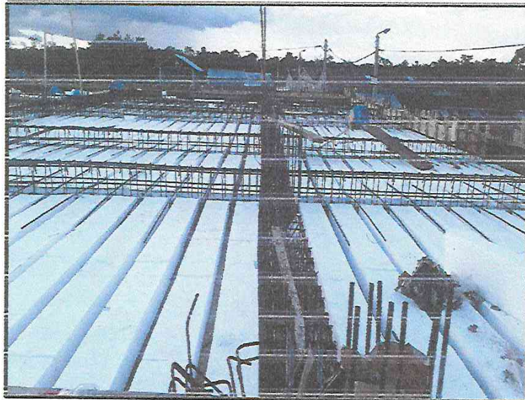
HABILITACIÓN E INSTALACIÓN DE BLOQUES DE TECNOPORT PARA LOSA ALIGERADA.
