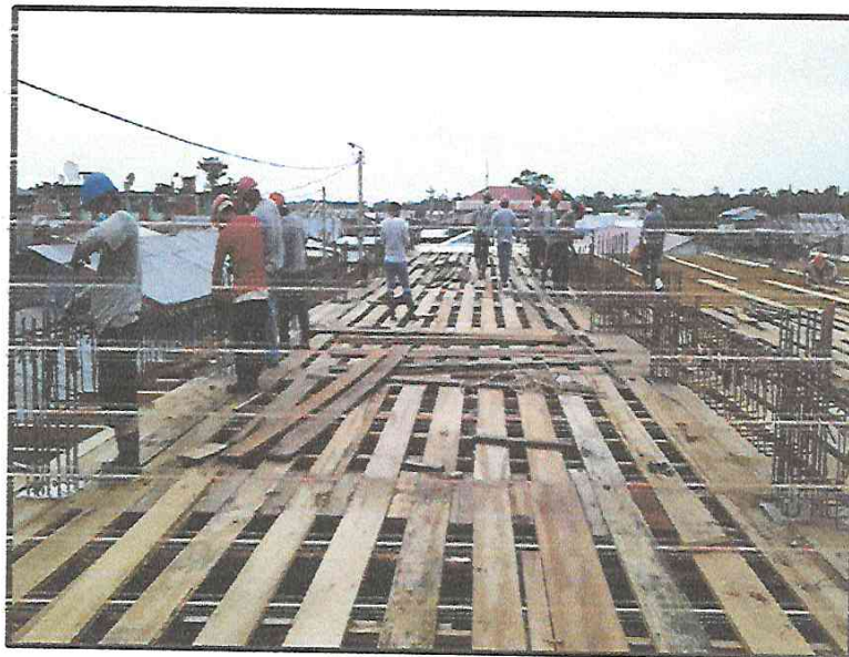
HABILITACIÓN DE ACERO CORRUGADO EN VIGAS.
