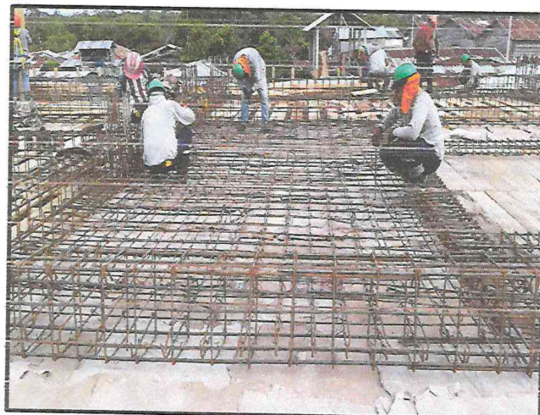
HABILITACIÓN DE ACERO EN LOSA ALIGERADA.
