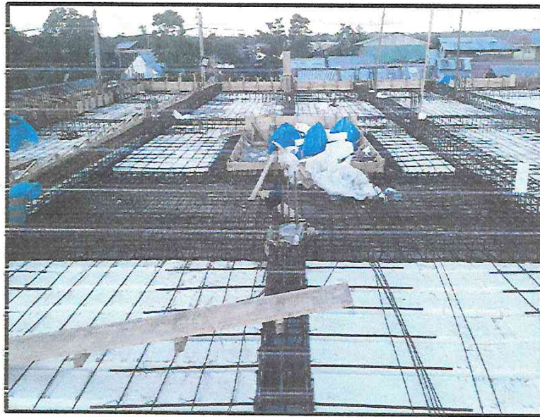
REFUERZO CON ACERO PARA BLOQUES DE TECNOPORT EN LOSA ALIGERADA.
