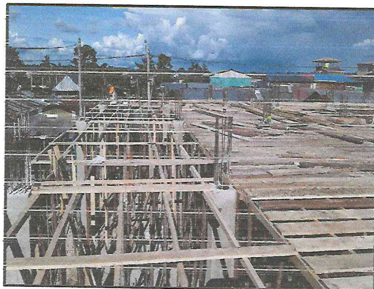
HABILITACIÓN DE ENCOFRADO PARA LOSA ALIGERADA.
