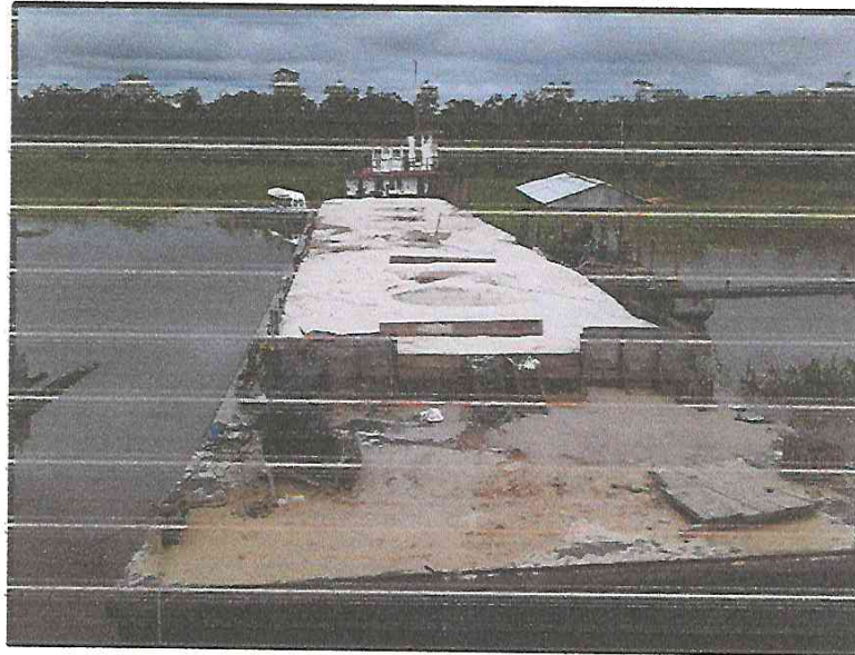
TRANSPORTE DE MATERIAL PARA LA OBRA.
