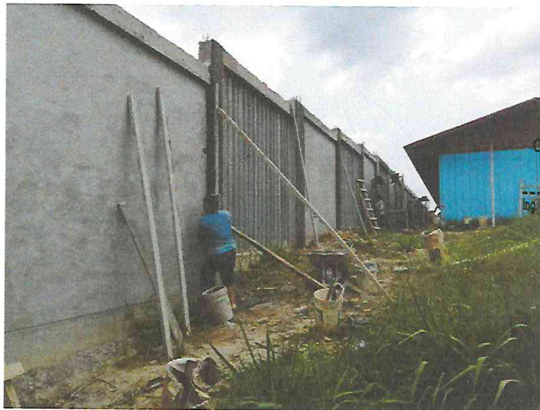
FOTO N°02: Vista de los trabajos de tarrajeo frotachado de columnas y vigas del muro perimétrico tramo 2 en la obra "Mejoramiento y Equipamiento del servicio Educativo N° 62200 Barrio Carabanchel - San Lorenzo, Distrito Barranca, Provincia Datem Del Marañón - Loreto".
