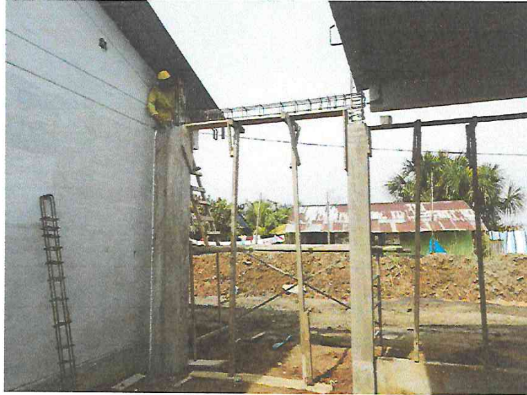
FOTO N°05: Vista de la habilitación y colocación de acero de refuerzo en portada de ingreso principal en la obra "Mejoramiento y Equipamiento del servicio Educativo N° 62200 Barrio Carabanchel - San Lorenzo, Distrito Barranca, Provincia Datem Del Marañón - Loreto".
