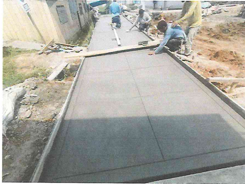
FOTO N°09: Vista del bruñado de vereda para conexión de módulo A al módulo B en la obra "Mejoramiento y Equipamiento del servicio Educativo N° 62200 Barrio Carabanchel - San Lorenzo, Distrito Barranca, Provincia Datem Del Maraón - Loreto".
