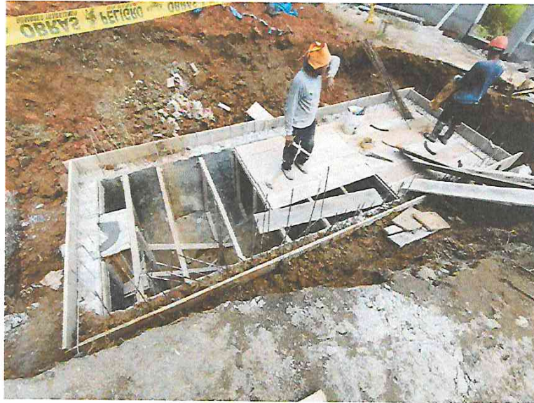
FOTO N°15: Vista del encofrado para el techo del tanque séptico en la obra "Mejoramiento y Equipamiento del servicio Educativo N° 62200 Barrio Carabanchel - San Lorenzo, Distrito Barranca, Provincia Datem Del Marañón - Loreto".
