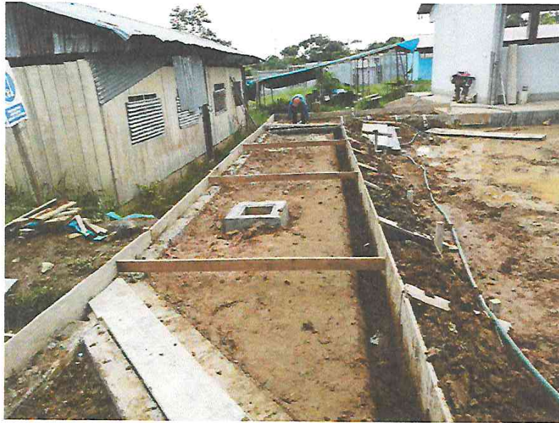
FOTO N°03: Vista del encofrado de vereda para la conexión del módulo A al módulo B en la obra "Mejoramiento y Equipamiento del servicio Educativo N° 62200 Barrio Carabanchel - San Lorenzo, Distrito Barranca, Provincia Datem Del Marañón - Loreto".
