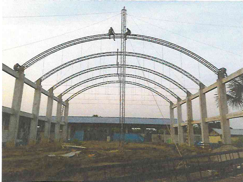
FOTO N°11: Vista habilitado de viga arqueada en la obra "Mejoramiento y Equipamiento del servicio Educativo N° 62200 Barrio Carabanchel - San Lorenzo, Distrito Barranca, Provincia Datem Del Marañón - Loreto".
