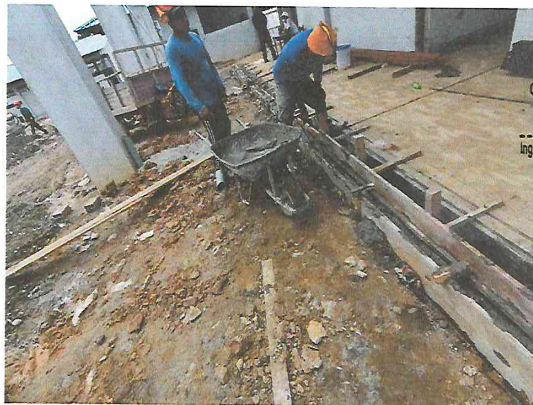
FOTO N°10: Vista vaco de mortero f_c = 175 \text{ kg/cm}^2 de cuneta frontal del módulo F en la obra "Mejoramiento y Equipamiento del servicio Educativo N° 62200 Barrio Carabanchel - San Lorenzo, Distrito Barranca, Provincia Datem Del Maraón - Loreto".
