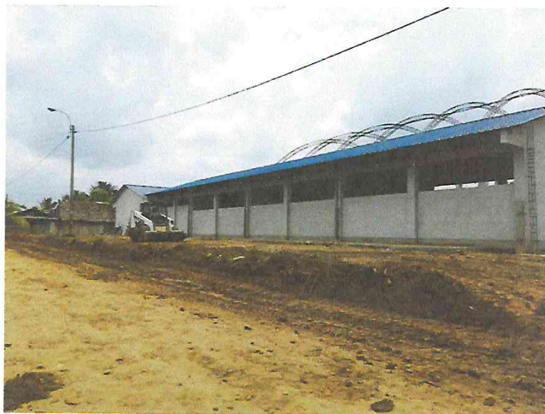
FOTO N°13: Vista de maquinaria trabajando en el exterior en la obra "Mejoramiento y Equipamiento del servicio Educativo N° 62200 Barrio Carabanchel - San Lorenzo, Distrito Barranca, Provincia Datem Del Marañón - Loreto".
