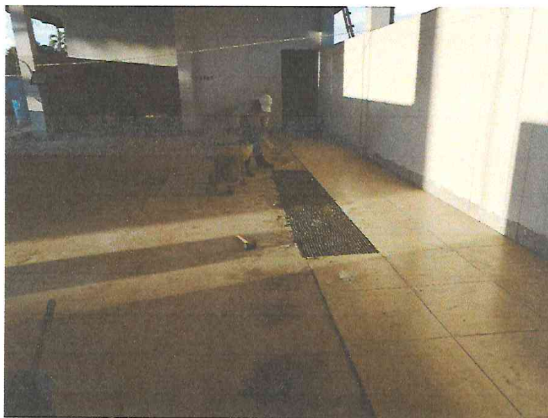
FOTO N°17: Vista de enchapado en piso de porcelanato en el módulo B - SUM en la obra "Mejoramiento y Equipamiento del servicio Educativo N° 62200 Barrio Carabanchel - San Lorenzo, Distrito Barranca, Provincia Datem Del Marañón - Loreto".
