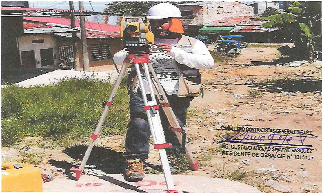
Foto N° 14: Trazo nivel y replanteo con estación total.
