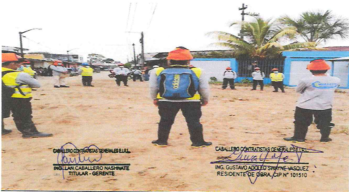
Foto N° 04: Charlas de seguridad y salud en obra, duración 10 min.
