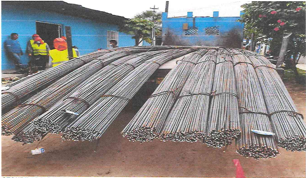
Foto N° 03: Transporte de materiales a obra.
