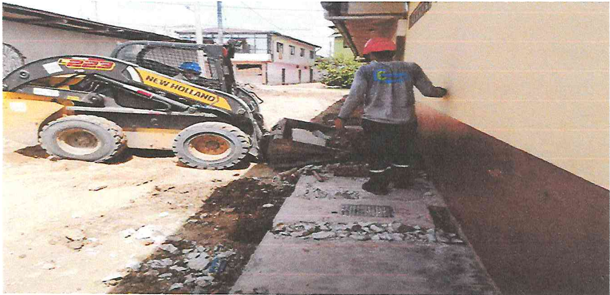
Foto N° 14: Demolición de veredas existentes con maquinaria.
