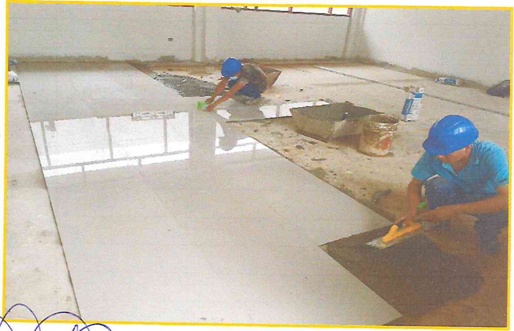
FOTO N°10: Enchapados de los Pisos en Interiores de los Módulos.
