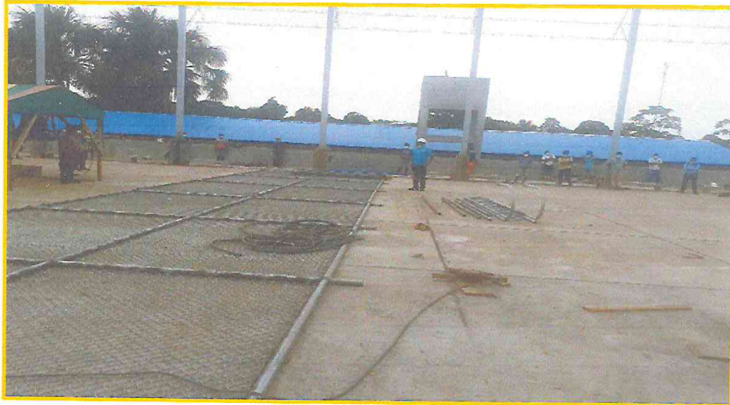
FOTO N°03: Se Observa Charlas de Bioseguridad de Obra.
