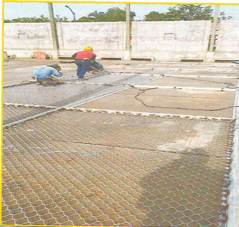
FOTO N°08: Confección de Malla Metálica Olímpica en Interior de la Cuneta de la Cancha.
