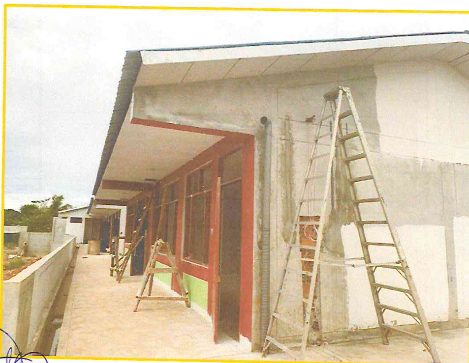
FOTO N° 14: Se Observa los Trabajos de Pintado en Exteriores de Módulos.
