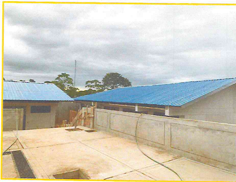
FOTO N° 13: Vista Panorámica de Techo Terminado.
