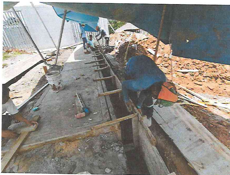
FOTO N°06: Vista del encofrado para cunetas exteriores en la obra "Mejoramiento y Equipamiento del servicio Educativo N° 62200 Barrio Carabanchel - San Lorenzo, Distrito Barranca, Provincia Datem Del Marañón - Loreto".
