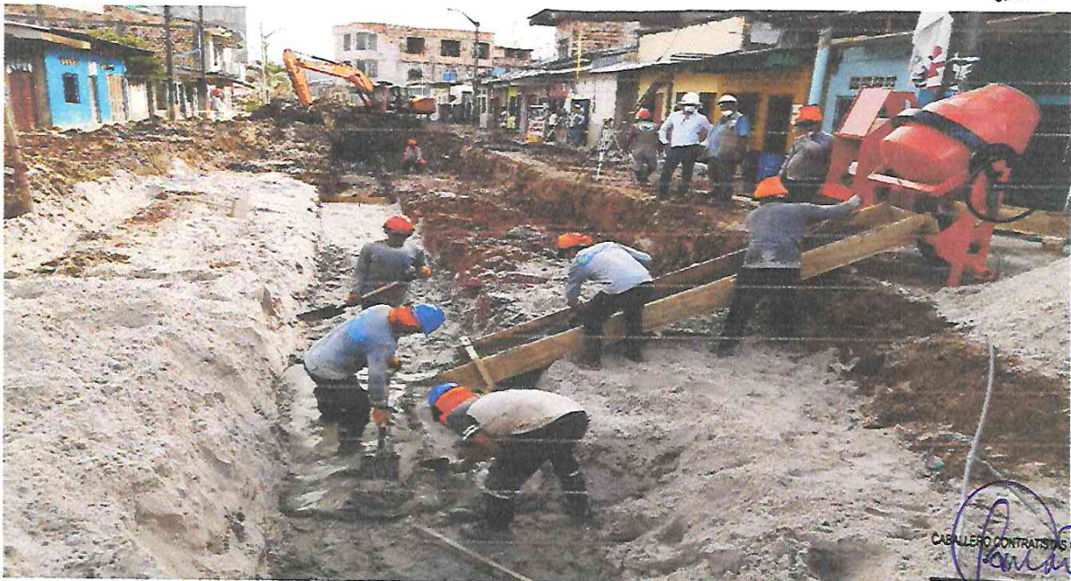
Foto N° 10: Relleno con material de préstamo A-2-4, Ca. Garcilazo de la Vega Tramo 8.
