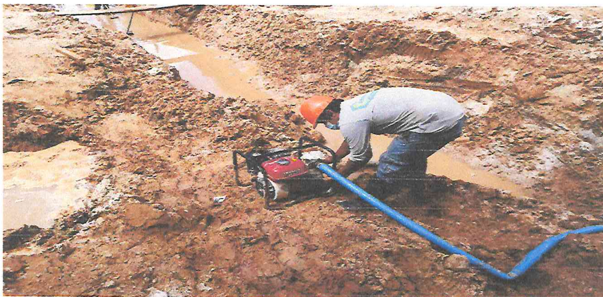
Foto N° 03: Bombeo para eliminación de aguas filtrantes y pluviales.
