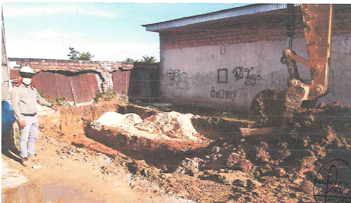
Foto N° 06: Corte de terreno a nivel de sobreexcavacion con maquinaria, Psje Libertad tramo 5.
