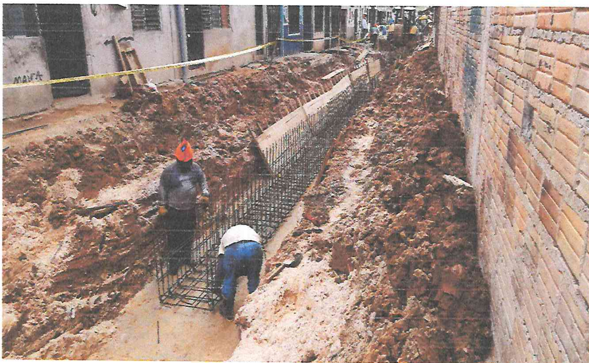
Foto N° 14: Encofrado de canal rectangular, Ca. Garcilazo de la Vega Tramo 8.
