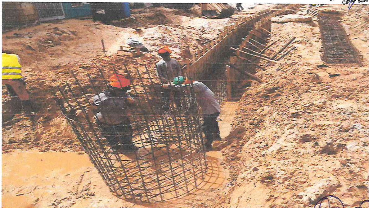
Foto N° 20: Acero de Refuerzo \varnothing 1/2 " y \varnothing 3/8 " de Buzón de Mortero Armado H=1.50m.
