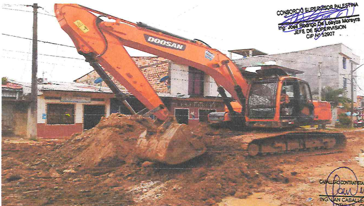
Foto N° 04: Corte de terreno a nivel de sobrexcaucion con maquinaria, Ca. Garcilazo de la vega tramo 8.
