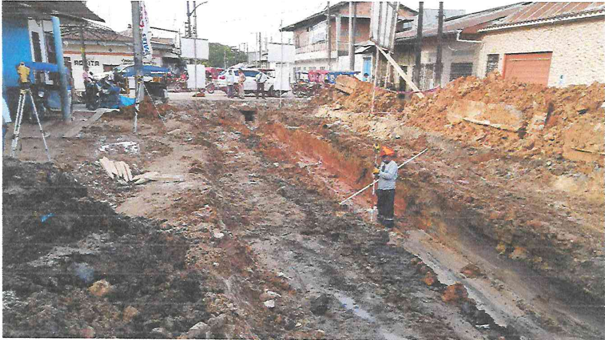
Foto N° 09: Excavación de Zanja con maquinaria hasta cota de fondo de alcantarilla, Ca. Garcilazo de la vega tramo 8.
