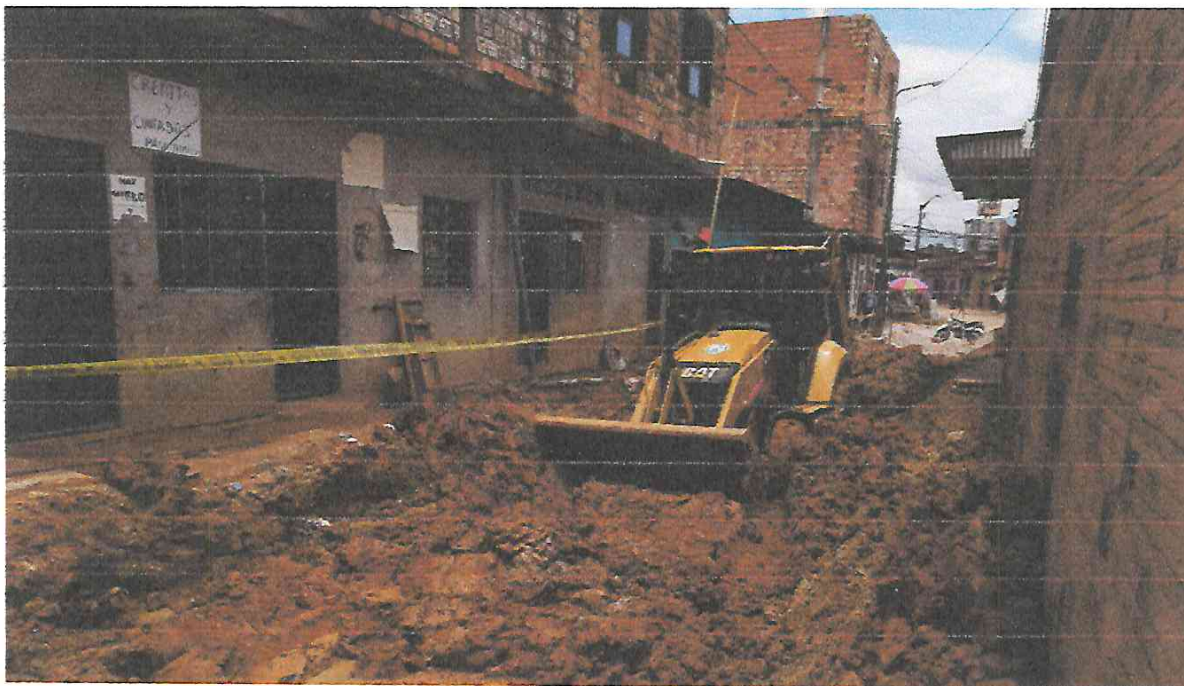
Foto N° 06: Corte de terreno a nivel de sobreexcavacion con maquinaria, Psje Libertad tramo 5.
