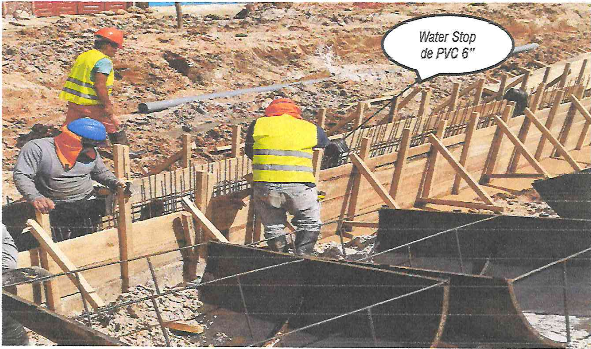
Foto N° 16: Mortero f'c=210Kg/cm2 (Canal rectangular) Ca. Garcilazo de la Vega Tramo 8.
