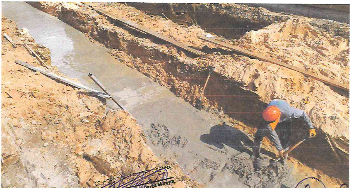
Foto N° 12: Solado para canal rectangular, mezcla c:a 1:10, e=4" Psje. Libertad Tramo 5.
