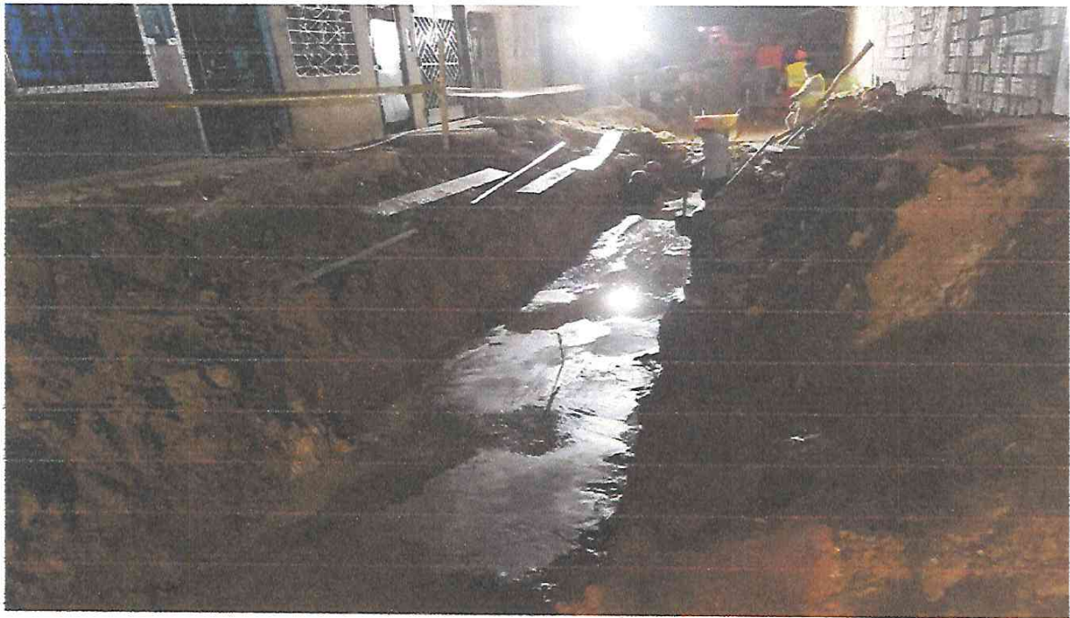
Foto N° 12: Solado para canal rectangular, mezcla c:a 1:10, e=4" Psje. Libertad Tramo 5.
