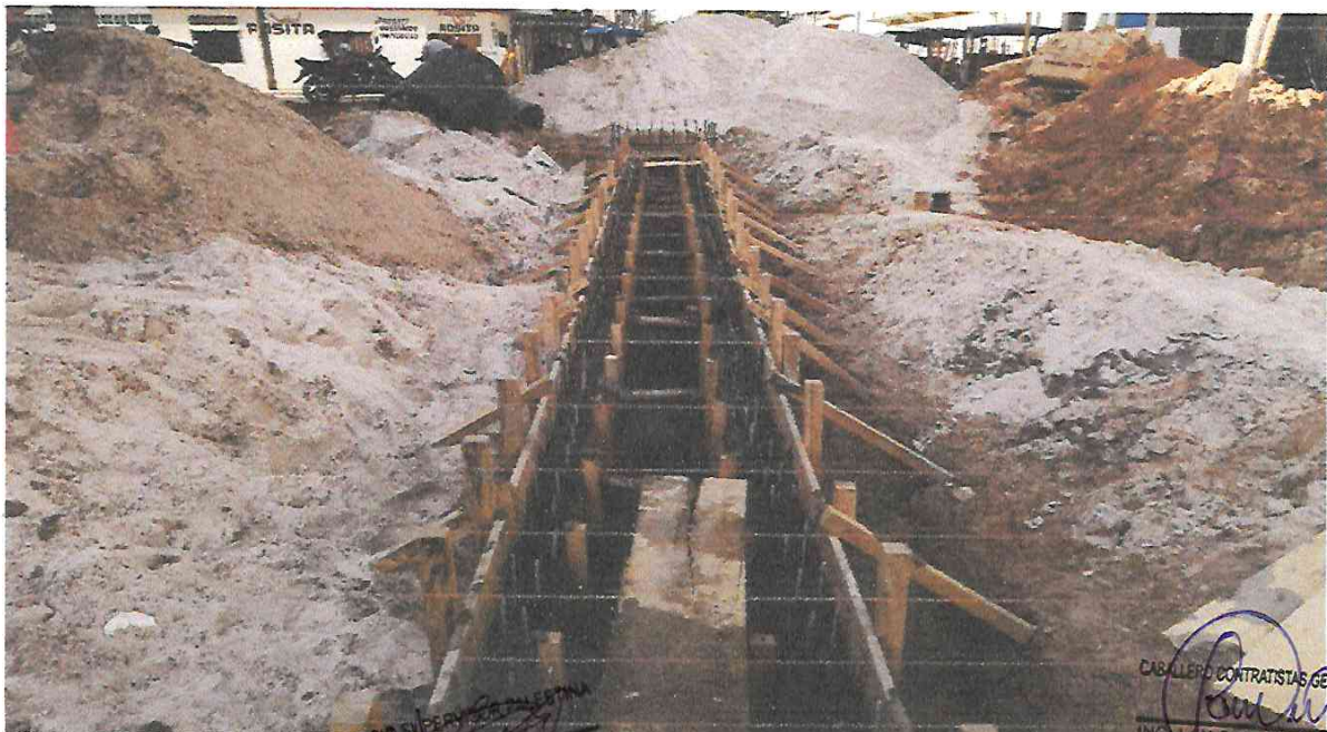
Foto N° 16: Mortero f'c=210Kg/cm2 (Canal rectangular) Ca. Garcilazo de la Vega Tramo 8.
