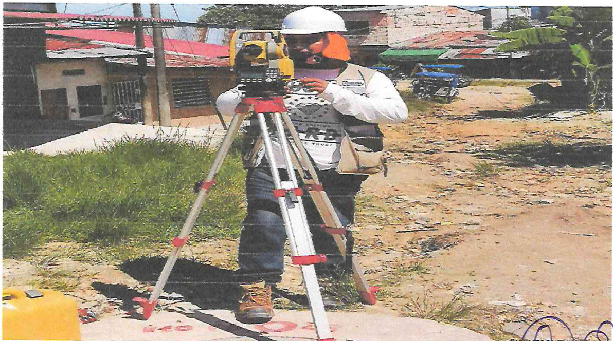
Foto N° 08: Trazo nivel y replanteo con estación total.
