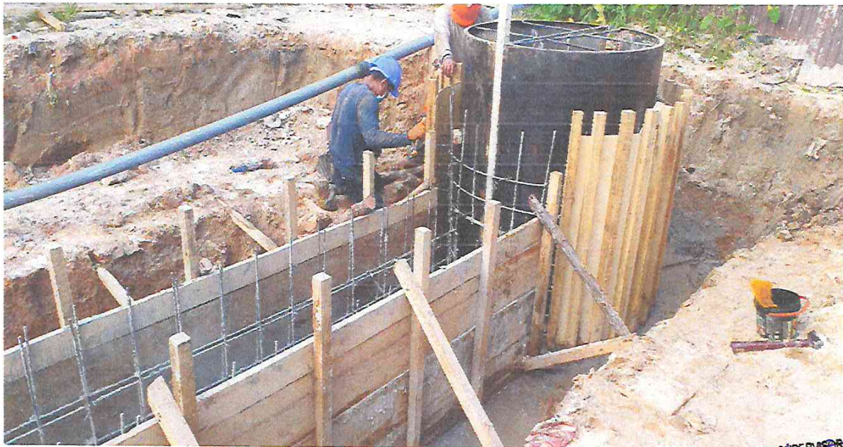
Foto N° 20: Acero de Refuerzo \varnothing 1/2 " y \varnothing 3/8 " de Buzón de Mortero Armado H=1.50m.
