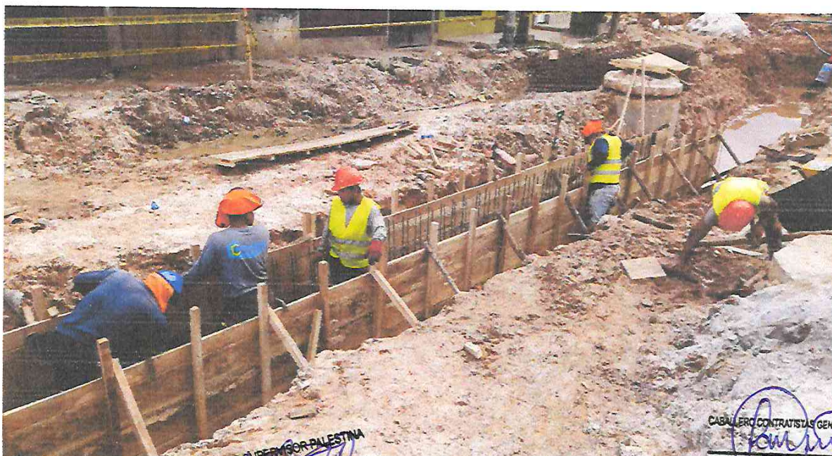
Foto N° 14: Encofrado de canal rectangular, Ca. Garcilazo de la Vega Tramo 8.
